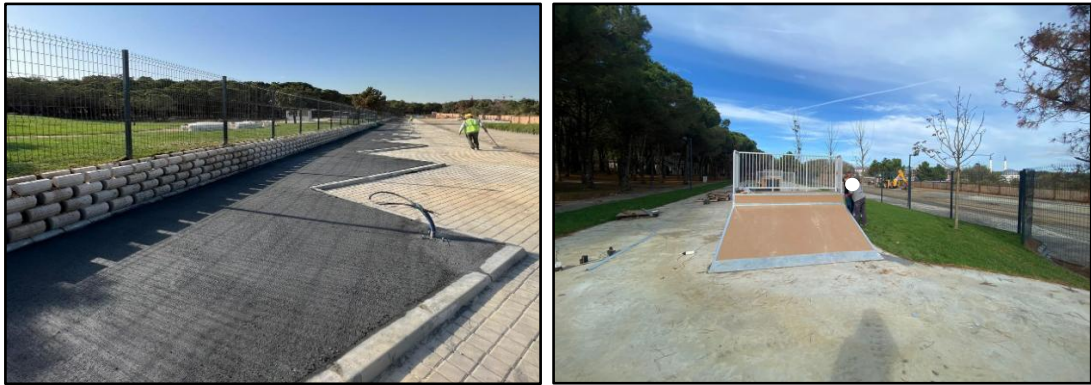
Şekil 34. Fırçalanmış süpürge beton ve helikopter perdahlı beton (Orijinal).
