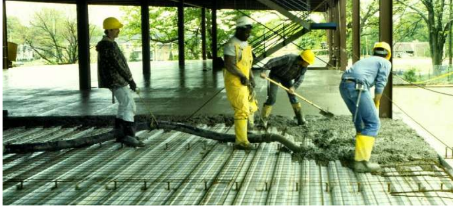
Şekil 2.2 Uygulamada beton dökümü
