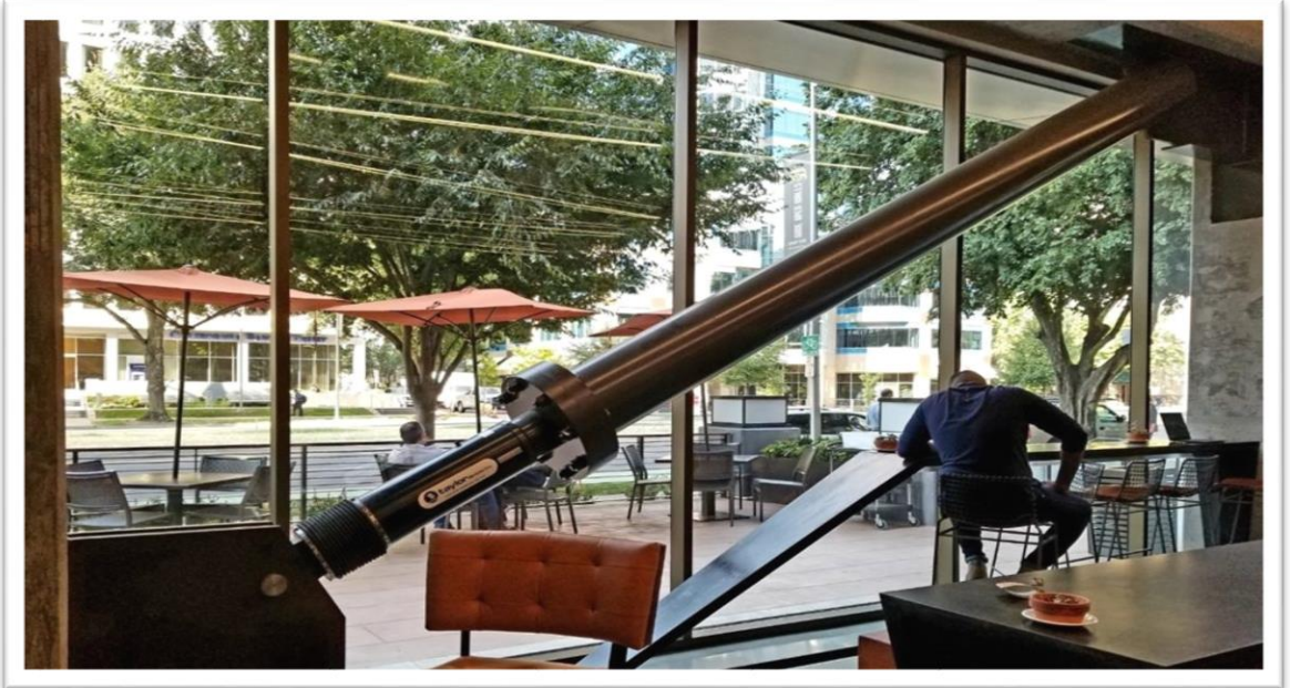
Şekil 2.40. Akışkan Viskoz Sönümleyicileri Diyagonal Tasarım
