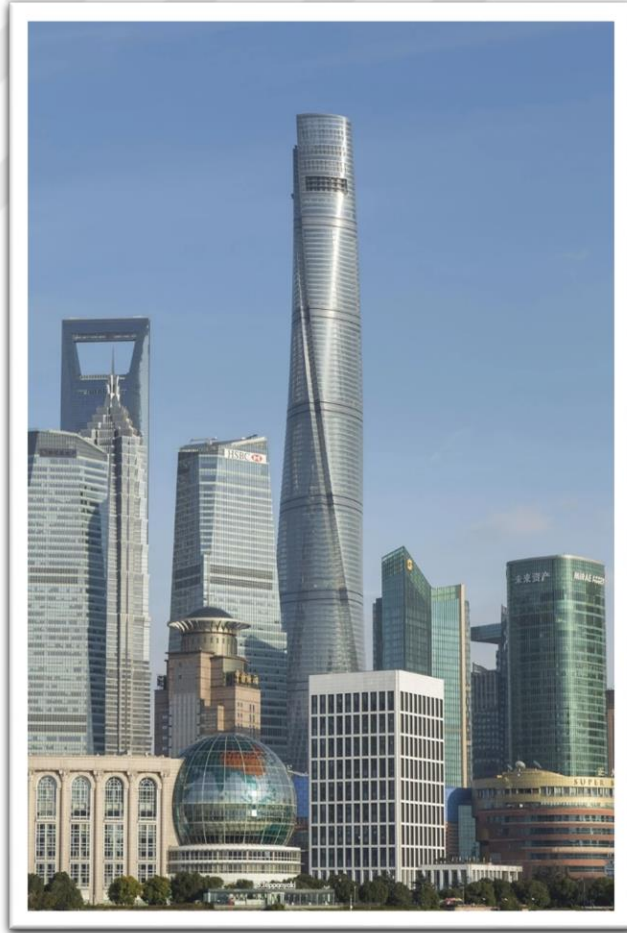
Şekil 2.20. Hibrit Kütle Sönümleyicileri Uygulaması (HTMD) Şanghay Kulesi / Çin
