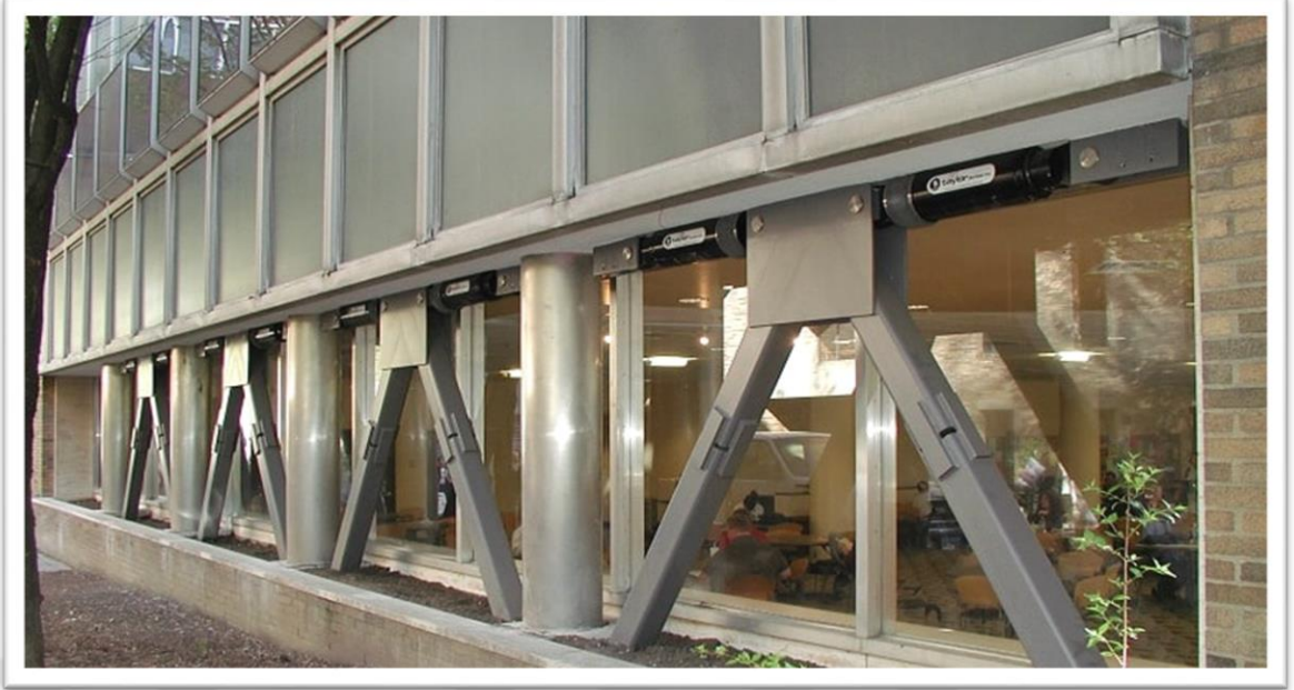
Şekil 2.38. Akışkan Viskoz Sönümleyicileri Değiştirilmiş Chevron Tasarım
