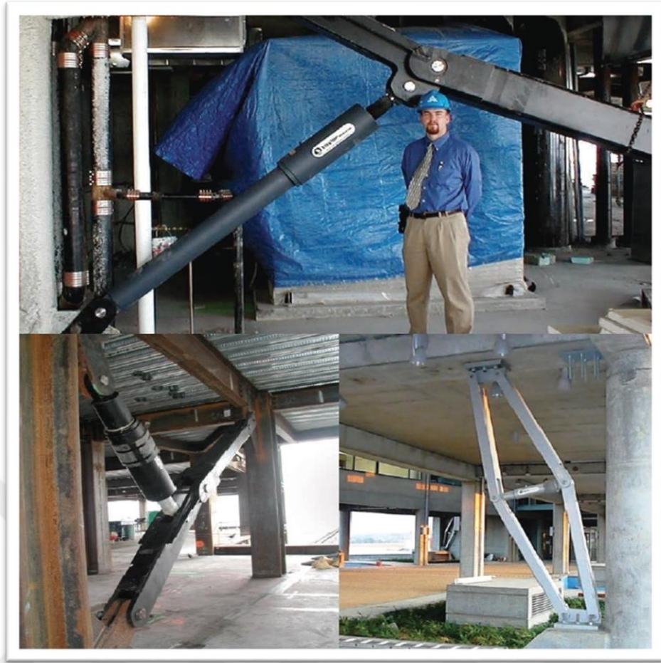
Şekil 2.42. Akışkan Viskoz Sönümleyicileri Toggle Tasarımı
