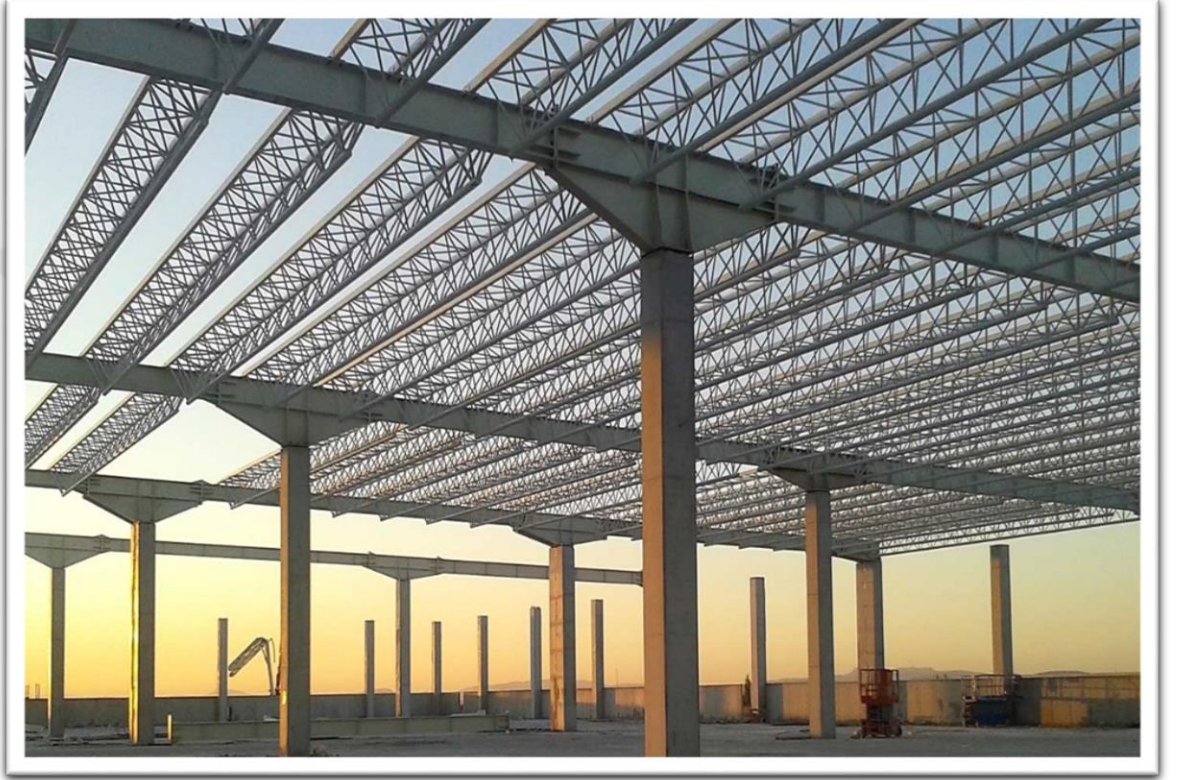
Şekil 2.12.2. Karma Taşıyıcı Sistemler (Endüstriyel Yapılar - Örnek)
