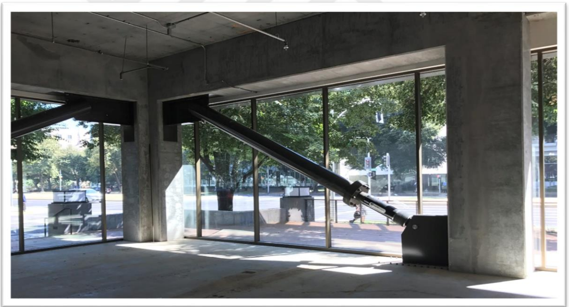
Şekil 2.47. Akışkan Viskoz Sönümleyicilerin Güçlendirme Uygulaması - Betonarme Yapılar (555 Capitol Mall / ABD)
