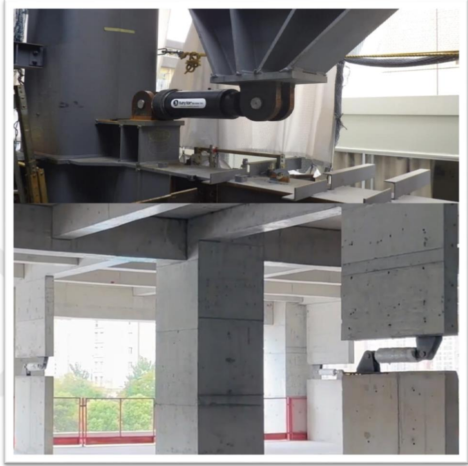
Şekil 2.37. Akışkan Viskoz Sönümleyicileri Kompakt Tasarım
