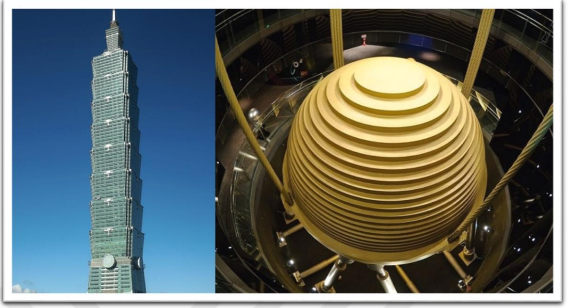
Şekil 2.18. Aktif Kütle Sönümleyici Sistem Uygulaması (AMD) Taipei 101 / Tayvan
