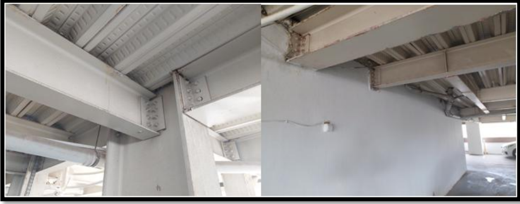
Şekil 56. Çelik kiriş birleşim detayı
