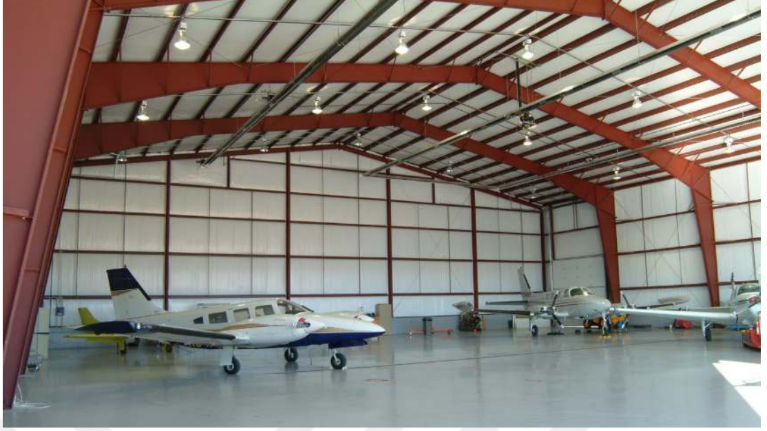
Şekil 1.4. Değişken kesitli çelik taşıyıcı sisteme sahip uçak hangarı (Sağır oğlu çelik uçak hangarı İstanbul).
