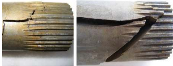
Şekil 3. 27. Diş dibinden başlayan çatlak sonrası hasara uğramış mil numuneleri
