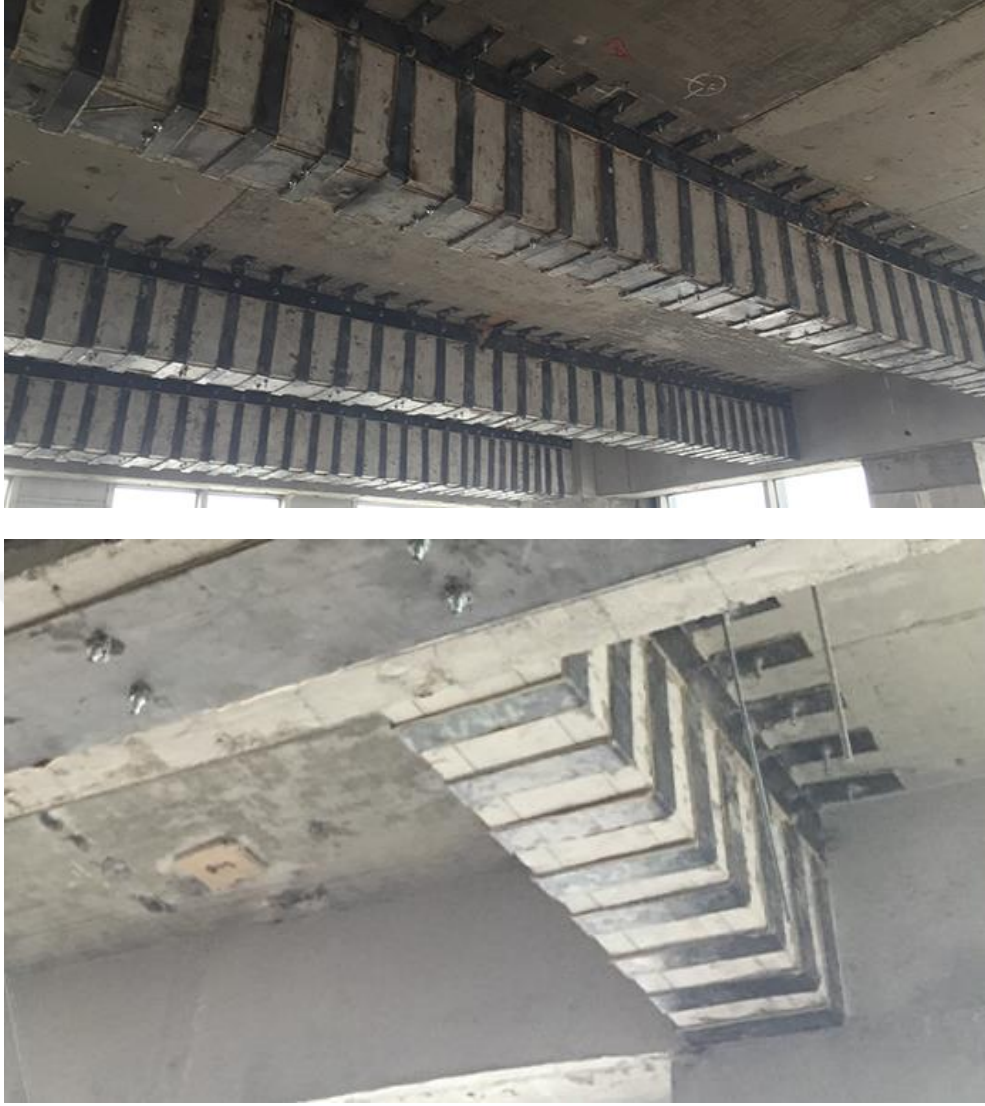
Şekil 3.2. Kirişlerde çelik levhalarla yapılan güçlendirme örneği
