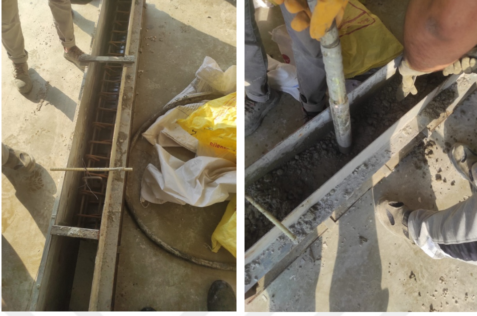
Şekil 3.6. Kiriş numune üretim aşaması
