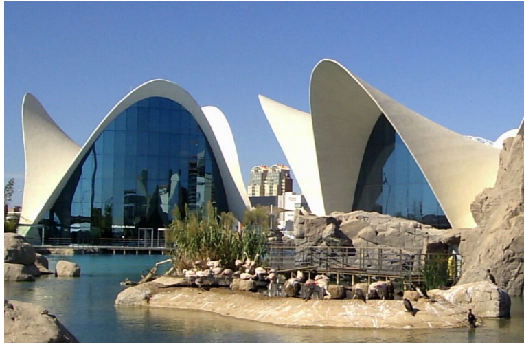
Şekil 1.1. Çelik lifli beton kullanımına örnek yapı (Blaszczynski ve Przybylska-Falek, 2015)
