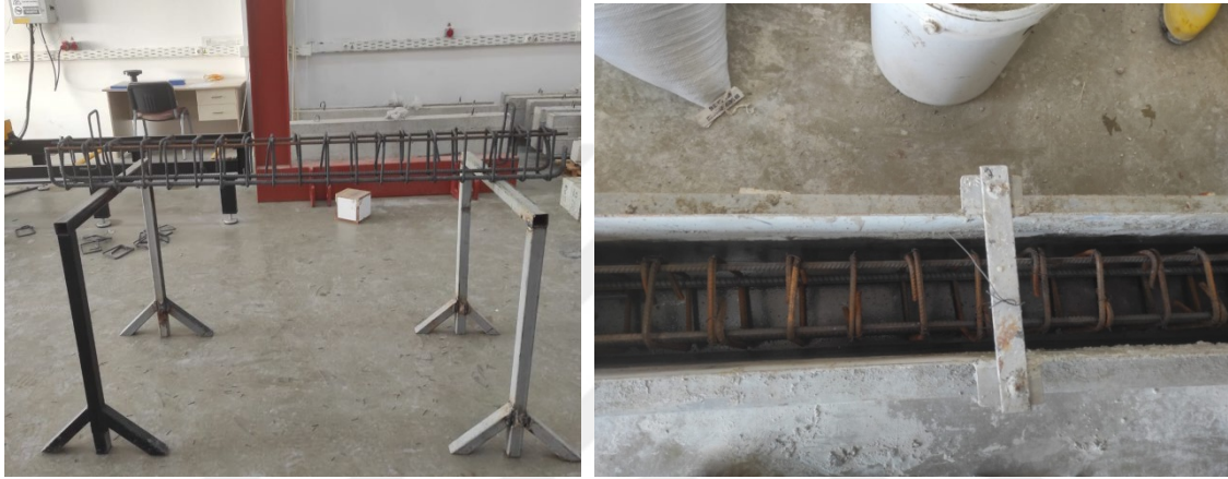
Şekil 3.4. Donatı hazırlığı ve kiriş kalıbının içine yerleştirilmesi
