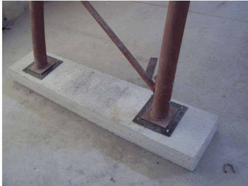
Şekil 8.8 Köprü ayaklarının görünümü.
