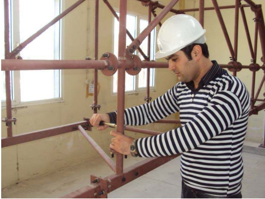
Şekil 8.13 Köprünün bağlantılarının belirli tork değeri ile sıkılması.
