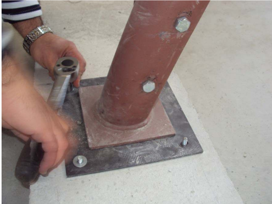
Şekil 8.10 Köprü ayaklarının dübellenmesi.
