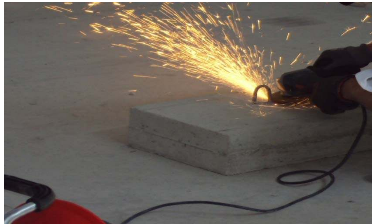
Şekil 8.4 Betonarme blokta bulunan kancaların kesilmesi.
