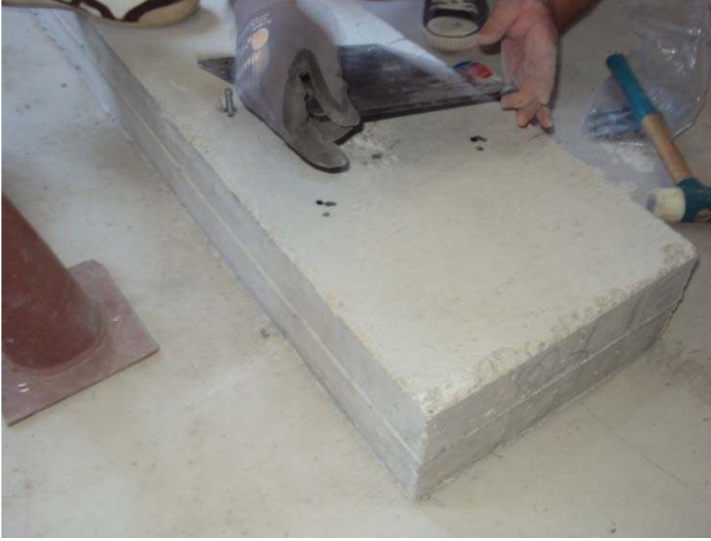
Şekil 8.9 Sacın betonarme plak üzerine yerleştirilmesi.
