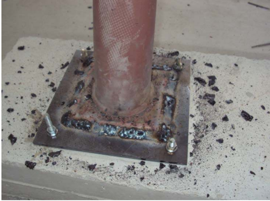
Şekil 8.11 Köprü Ayaklarının Kaynaklanarak Mesnetlenmesi.
