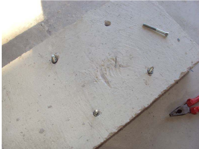
Şekil 8.6 Betonarme bloğa dübellerin yerleştirilmesi.
