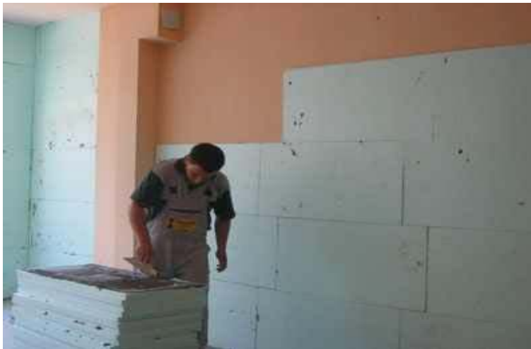
Resim 4.14.İçten ısı yalıtım uygulaması örneği
