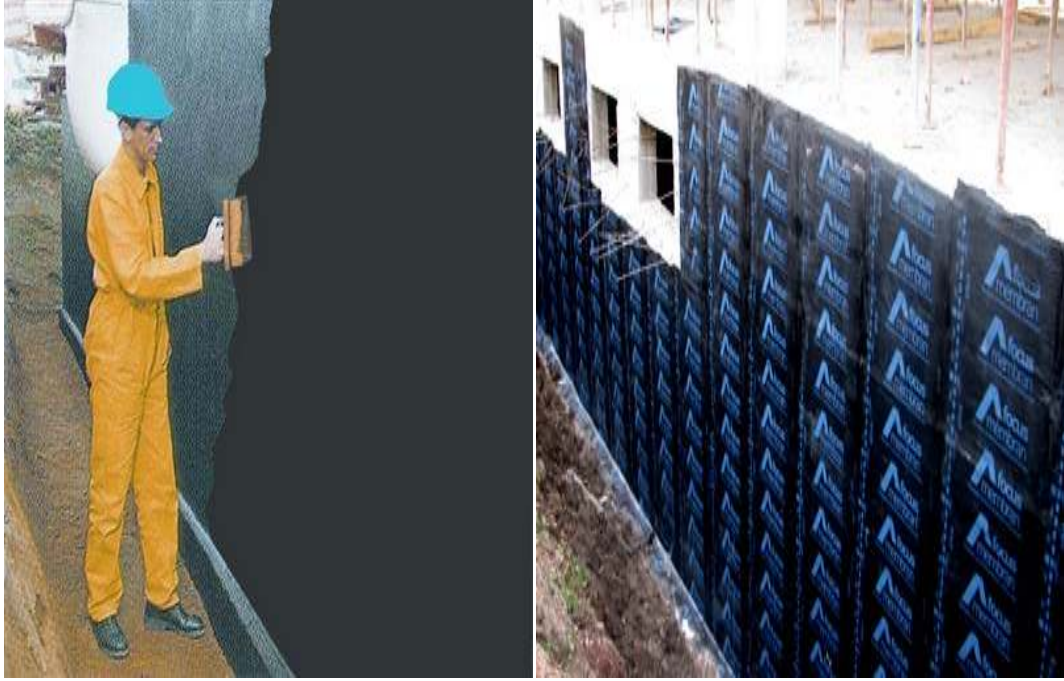
Resim 4.3. Duvara su yalıtımı uygulaması yapılışı
