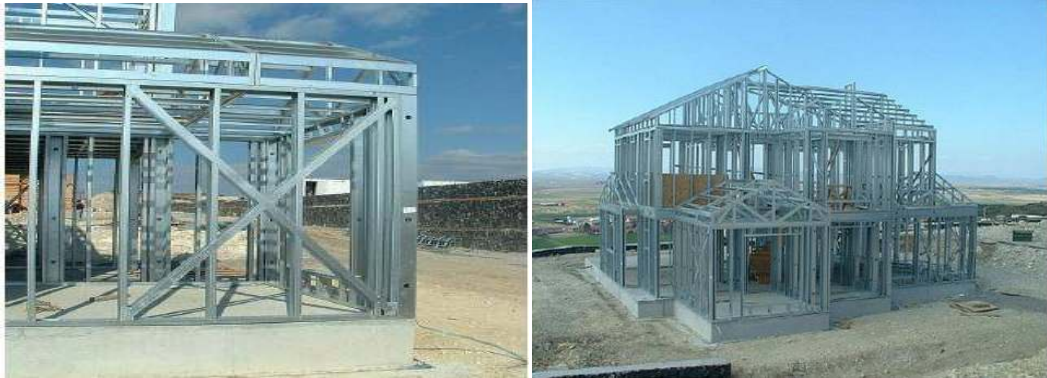
Resim 3.8. Prefabrik yapının taşıyıcı sistemlerinin, tamamlanmış hali [3]
