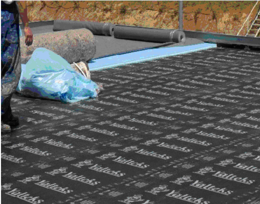
Resim 4.1. Temelde basınçsız suya karşı yalıtım uygulaması
