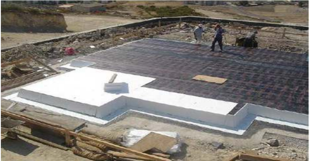
Resim 3.6.Çelik prefabrik yapıya ait temel ve su yalıtımının uygulanışı [6]
