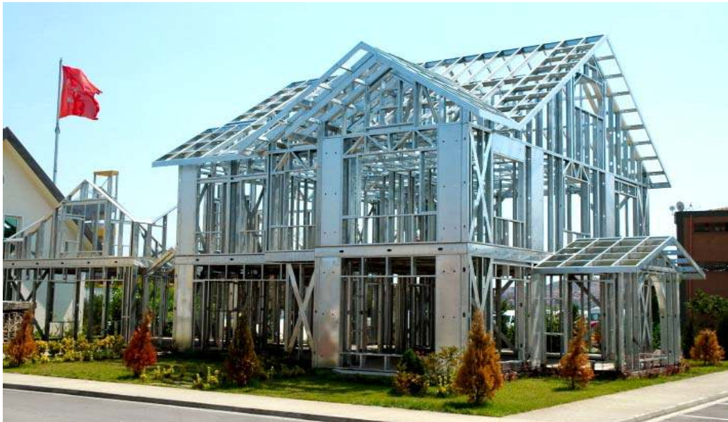
Resim 3.1. Çelik prefabrik yapıların taşıyıcı sistem görünüşü [3]
