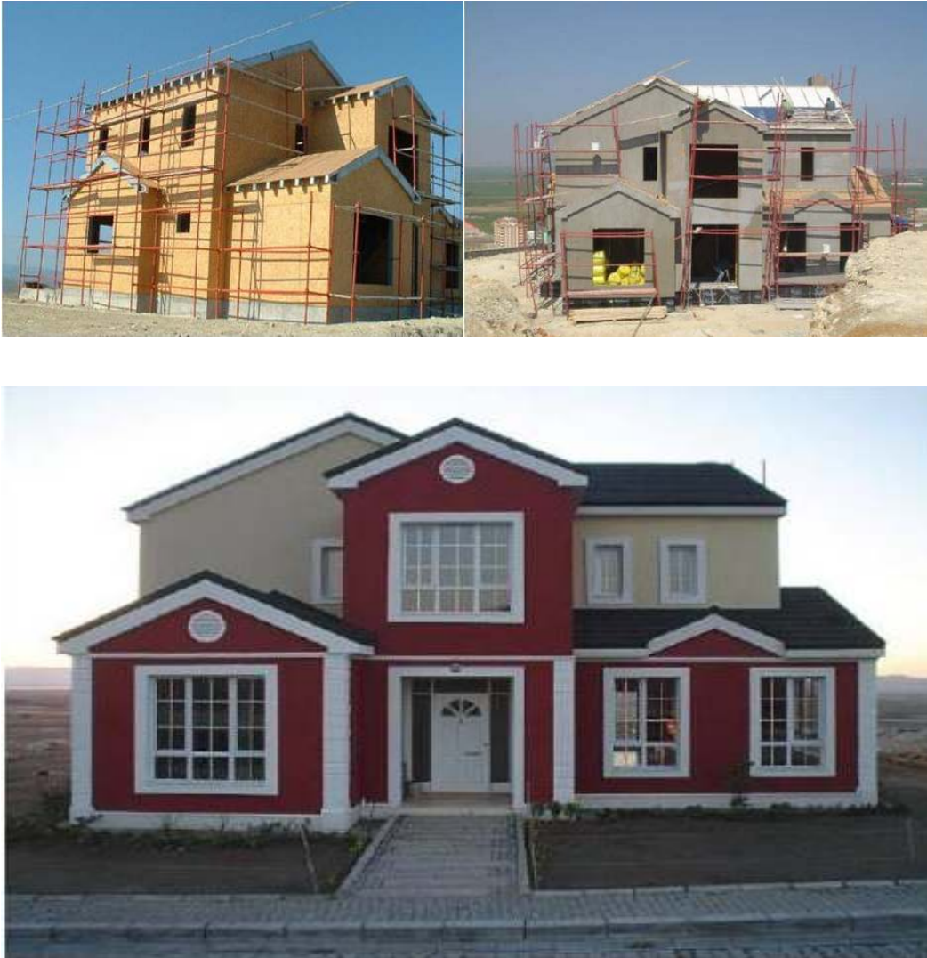
Resim 3.9. Çelik prefabrik yapının dış cephe kaplaması bitmiş hali [3]
