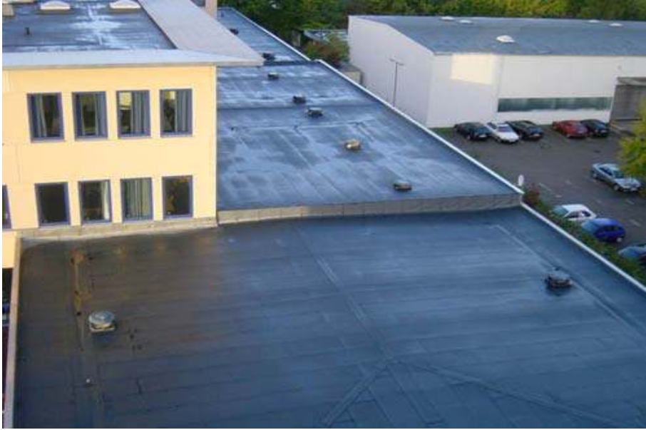
Resim 4.8. Gezilmeyen çatıda su yalıtım uygulaması görünüşü
