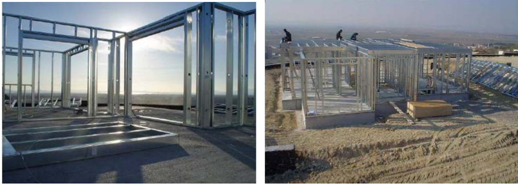
Resim 3.7. Çelik prefabrik yapıların, montaj evrelerini [3]
