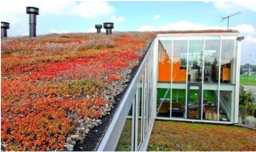
Resim 4.9. Örnek bahçe çatı görünüşü [9]
