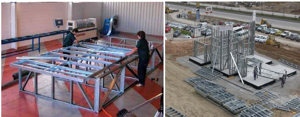
Resim 3.3. Prefabrik yapıların duvar panolarının hazırlanışı ve montajı [3]
