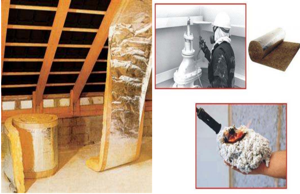
Resim 4.10. Çatıda ve tesisatlarda yangın yalıtım uygulaması [10]
