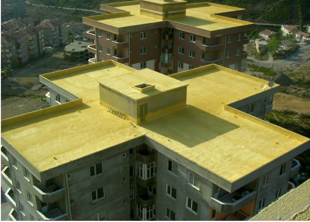
Resim 4.20. Terasta poliüretan yalıtımı uygulaması [21,22]
