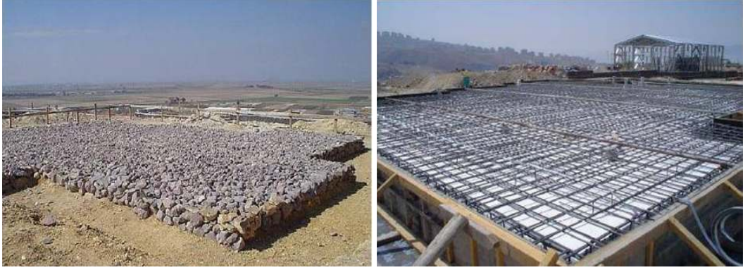
Resim 3.4. Temel blokajı hazırlanması ve donatı bağlantısının yapımı [6]
