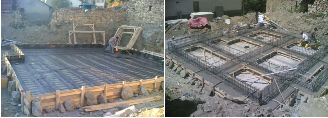
Resim 3.5. Temel yalıtımı ve temel kirişlerinin hazırlanışı [6]
