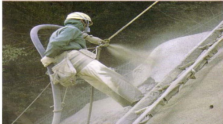
Şekil 2.7. Çelik liflerin şev stabilitesinde kullanımı
