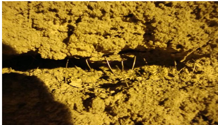
Şekil 2.8. Çelik liflerin şev stabilitesinde kullanımı
