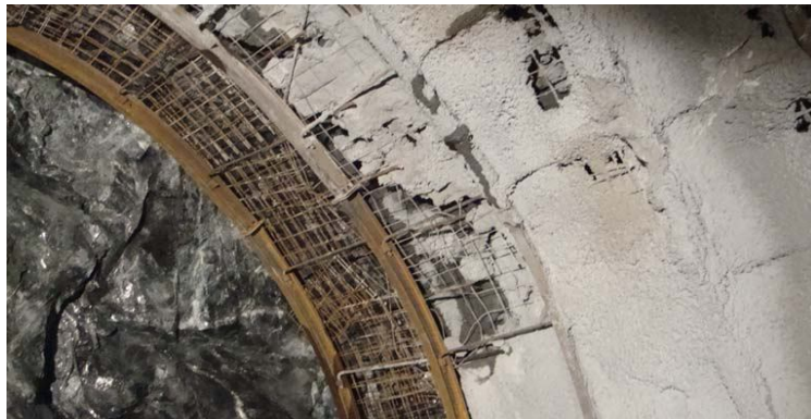
Şekil 2.5. Çelik liflerin tünelde püskürtme betonda kullanımı
