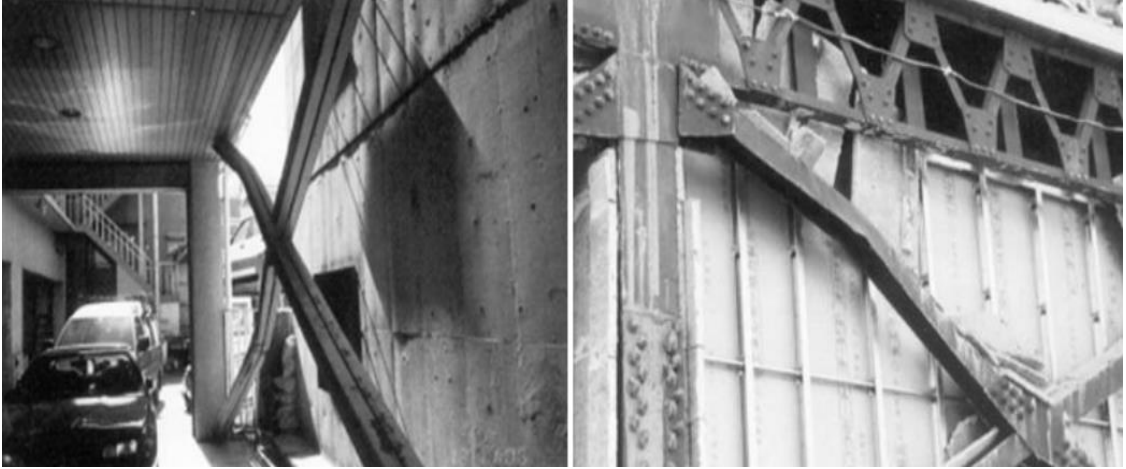
Şekil 3. Merkezi çelik çaprazlarda burkulma hasarları (Aguero ve diğ. 2006)
