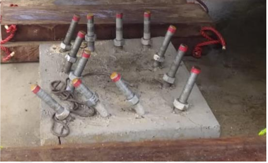
Şekil 3.3. Ankraj deliklerinin kaymasından kaynaklanan ankraj bozuklukları
