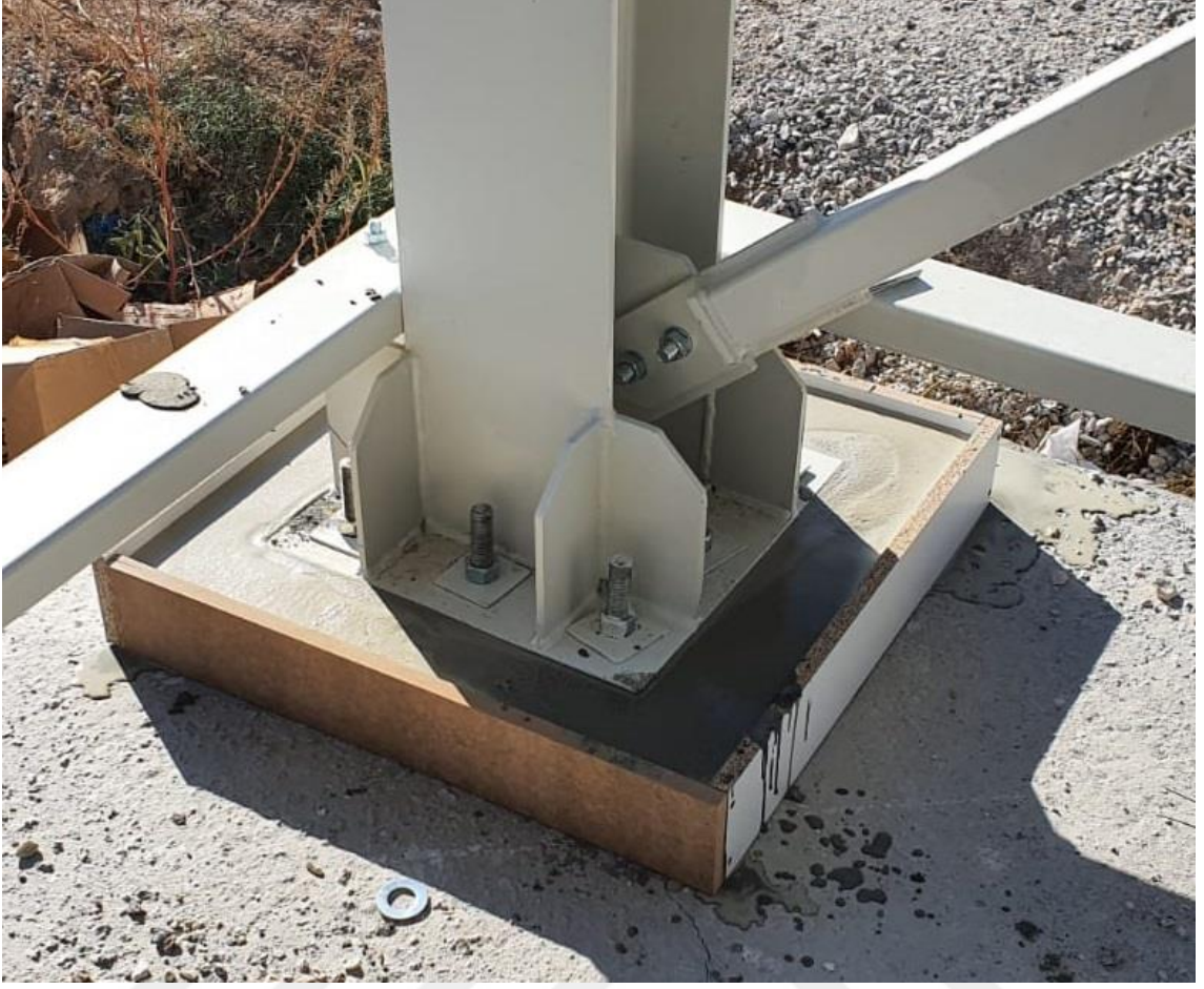
Şekil 3.5. Ankraj yerleşiminde grout uygulaması örneği
