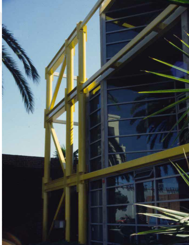
Şekil 2.3. Çerçeve sistem imal edilen ofis binası
