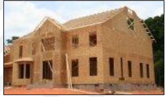
Fotoğraf 2.4 OSB Ev uygulaması (URL-4, 2023)
