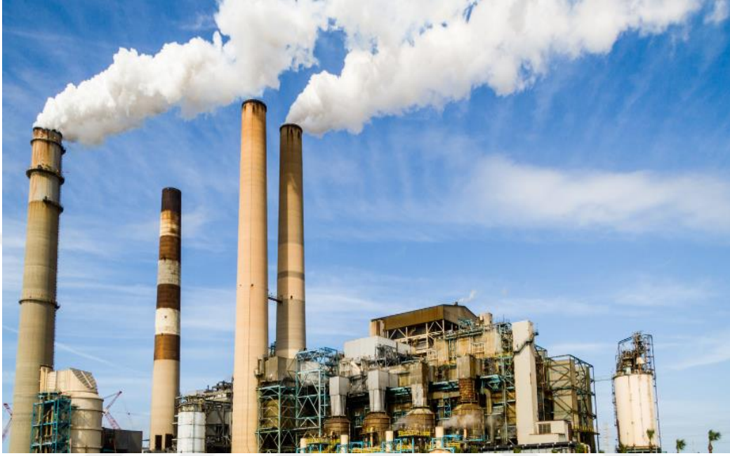
Şekil 2.5. Sanayi Faaliyetleri Sonucunda Oluşan Hava Kirliliği (DEMSA Baca ve Havalandırma Sistemleri)
