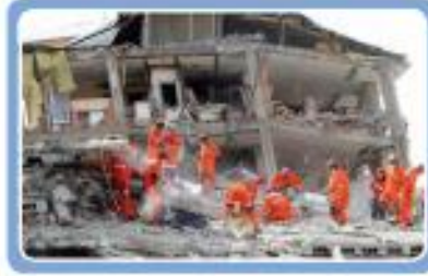
Depremde binalar yıkılır.
