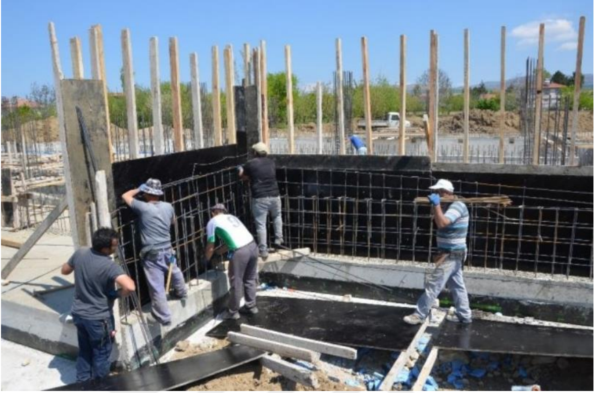
Görsel 4.8. Havuz perde kalıpları ve demir donatıları yapılan başka bir havuz inşaatı
