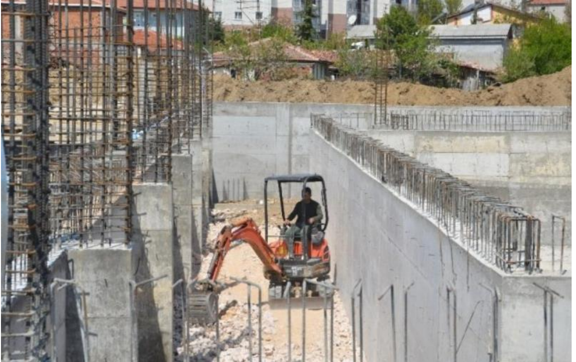
Görsel 4.7. Havuz perdeleri yapılan başka bir havuz inşaatının görünüşü
