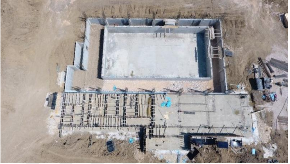
Görsel 4.6. Yüzme havuzu kaba inşaatı, havuz perdeleri, galeri boşlukları ve dış perdeleri yapılan inşaatın üstten görünüşü (farklı bir havuz inşaatı fotoğrafıdır)
