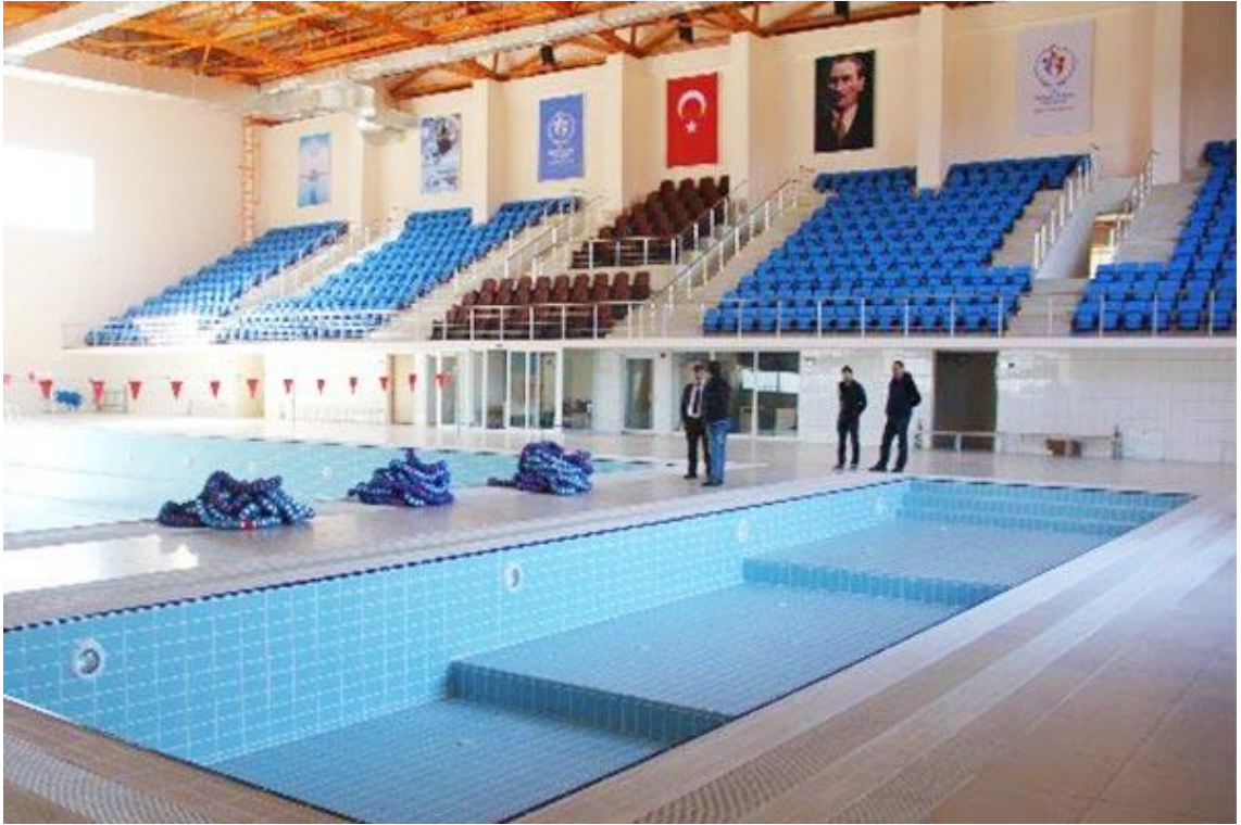
Görsel 1.6. Olimpik yüzme havuzu havuz derinleşme detayı
