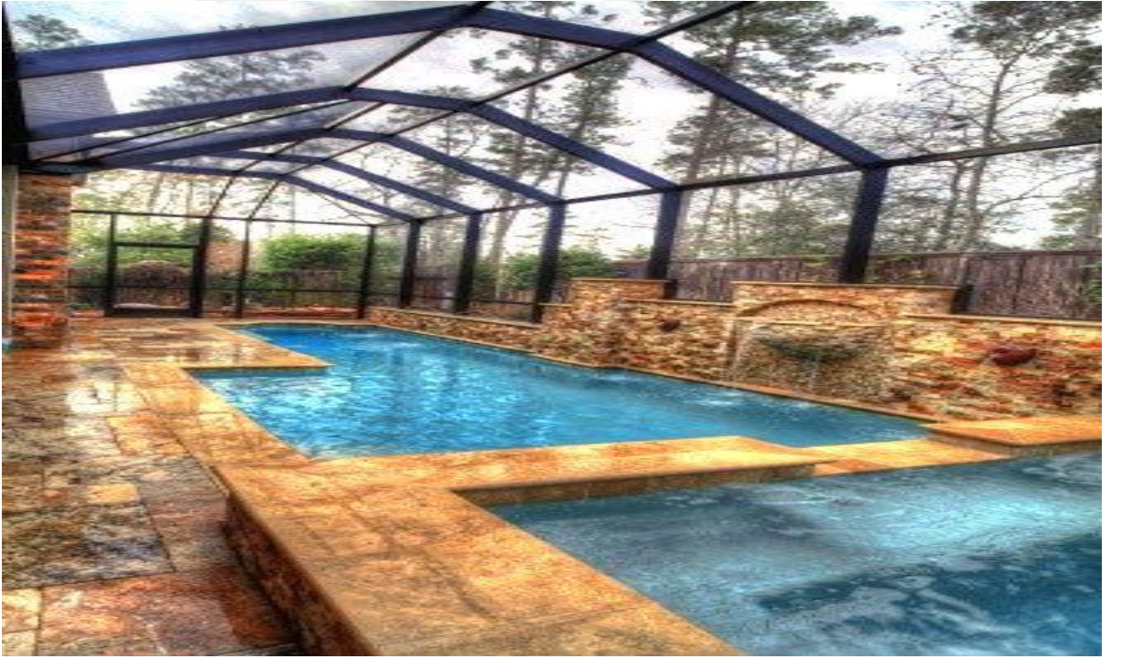
Görsel 2.18. Turistik tesis değişik traverten mermer kaplama kullanılmış kaplıca havuzu kısmı
