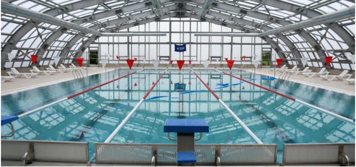
Görsel 2.3. Turistik tesis kapalı yüzme havuzu – çelik konstrüksiyon ve cam kapama sistemleri
