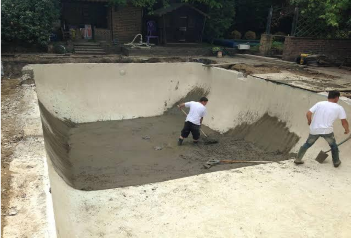
Görsel 4.9. Havuz içi sürme izolasyon ve izolasyonlu tesviye yapımı
