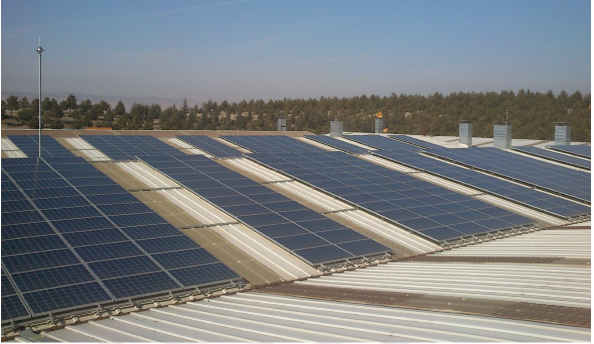
Şekil 6.6. İlk Lisanssız GES Çatı Uygulaması, Ankara-Kazan-II
