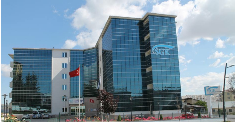
Şekil 5.3. SGK Sivas İl Md. Hizmet Binası
