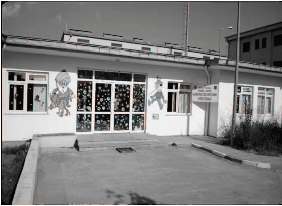
Resim 3-4. Cezaevi Kurumunda Bulunan Kreş Binaları
