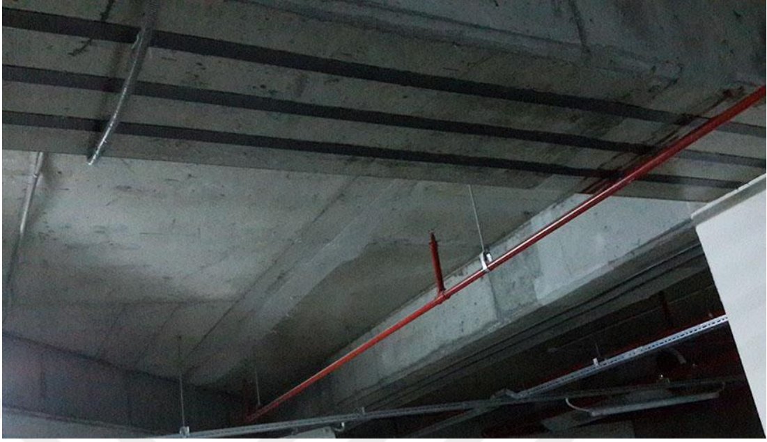
Şekil 2.3. FRP plaka uygulaması [20]
