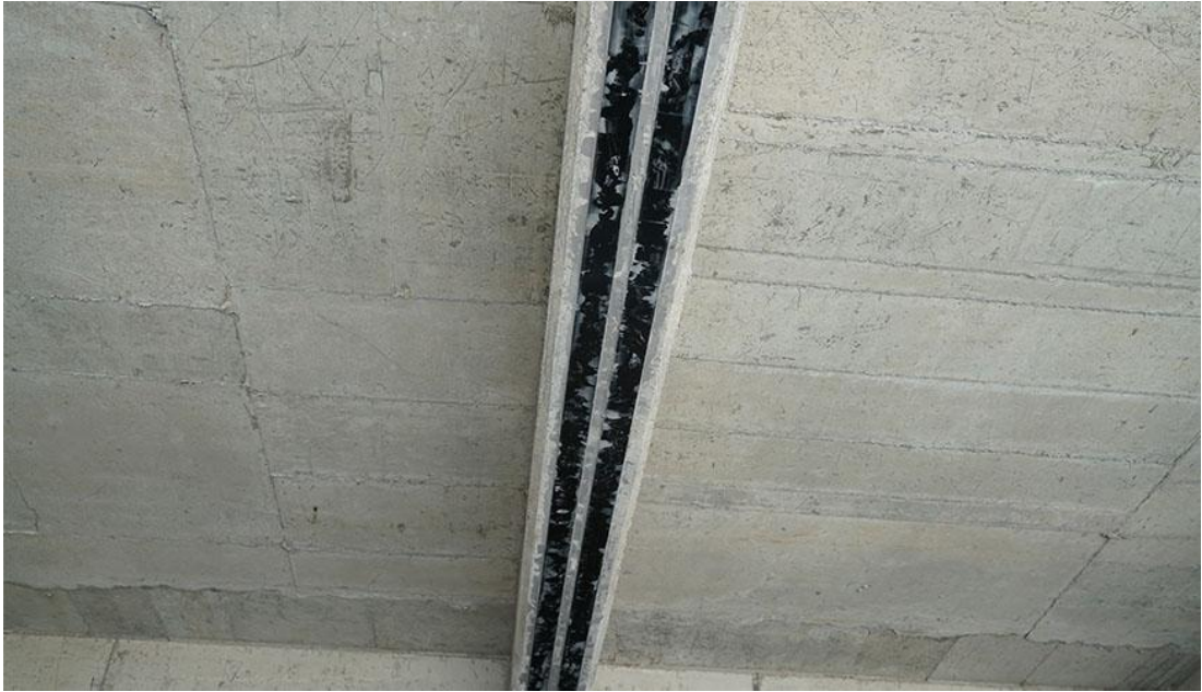
Şekil 2.4. FRP plaka uygulaması [20]
