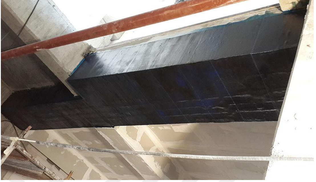
Şekil 2.7. FRP kumaş uygulaması [20]
