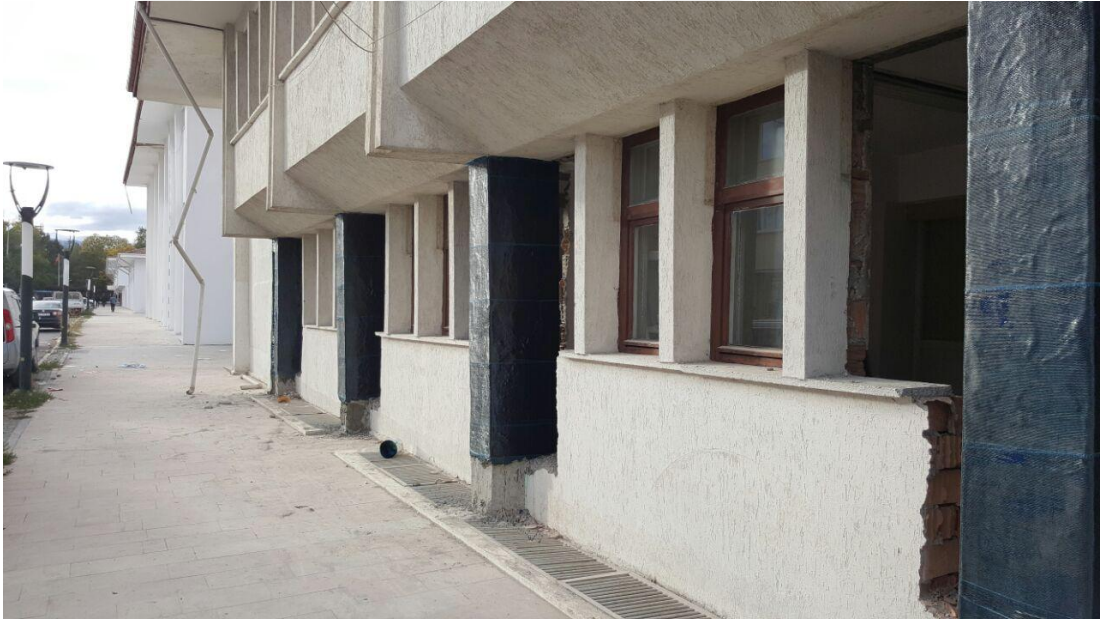
Şekil 2.8. Betonarme kolonlara FRP uygulaması [21]
