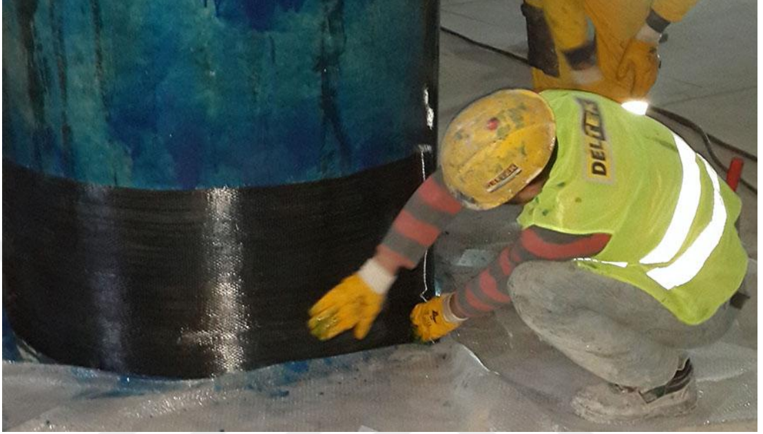
Şekil 2.5. FRP kumaş uygulaması [20]
