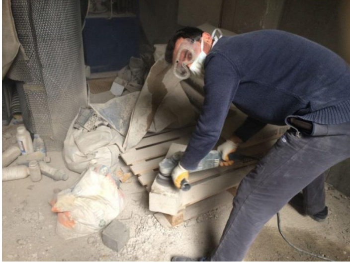
Şekil 3.19. CFRP yapışma yüzeylerinin taşlanması.
