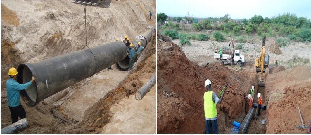
Şekil 4.1: İçme suyu projesi inşaatından bir kesit
