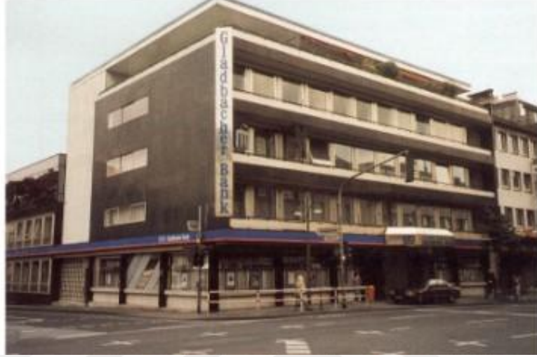
Şekil 2.38. Gladbacher Bank binası yenileme öncesi (Çetin, 2018)
