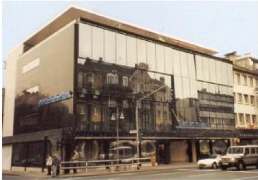
Şekil 2.39. Gladbacher Bank binası yenileme sonrası (Çetin, 2018)
