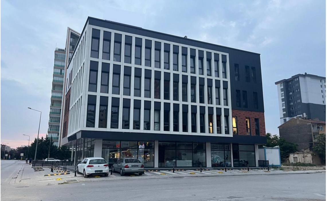
Şekil 3.3. Tez kapsamında üzerinde çalışılacak ofis binası
