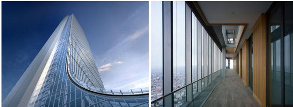
Şekil 2.12. İstanbul Sapphire Binası Görünüşü (URL- 8)
