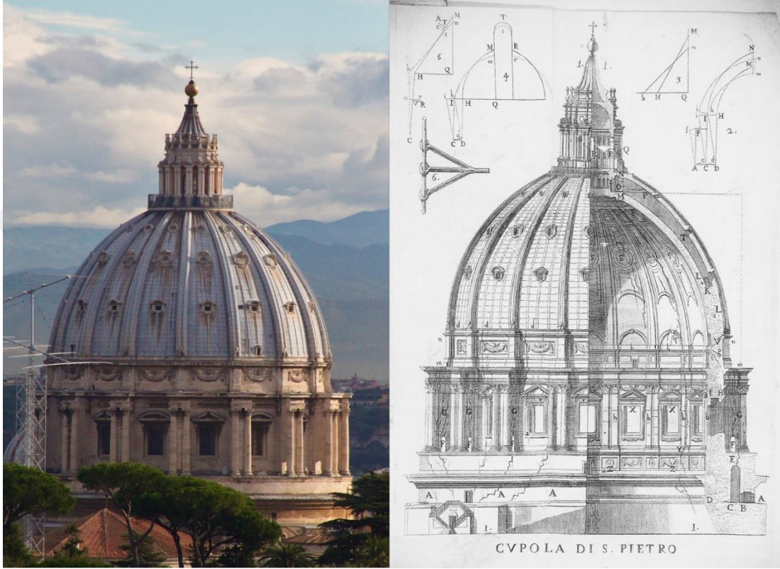
Şekil 2.21. Aziz Petrus Katedrali'nin çatlakları hakkında yapılan çalışma (Le Seur, 1742).
