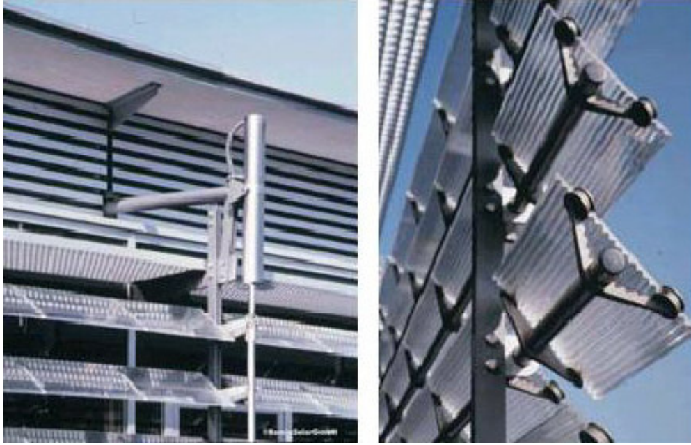
Resim 2.2. Sparkasse Fürstenfeldbruck binası cam güneş kontrol elemanları [16]
