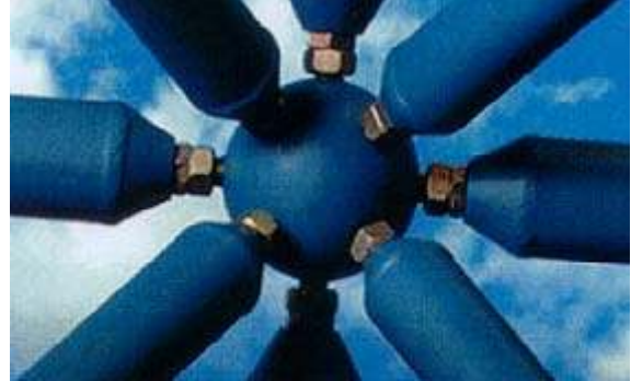
Şekil 3.1 Uzay Kafes Sistemlerde Düğüm Noktası (Küre Eleman)
