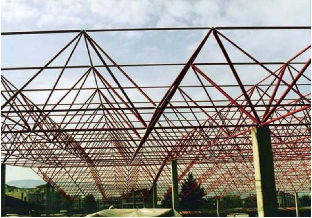
Şekil 2.3 Çok Büyük Açıklıklı Uzay Kafes Sistem
