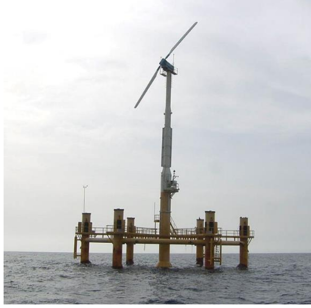
Fotoğraf 1.2. İtalya Apulia şehrinde kurulan ilk açık deniz yüzer rüzgâr türbini (Institute, 2008)
