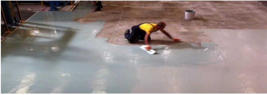
Şekil 2.2. Çatlak ve Kırıkların Tamirinde Epoksi Kullanımı
