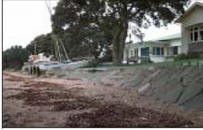
g) Eğimli kıyı duvarı (Cheltenham Beach) [1]
