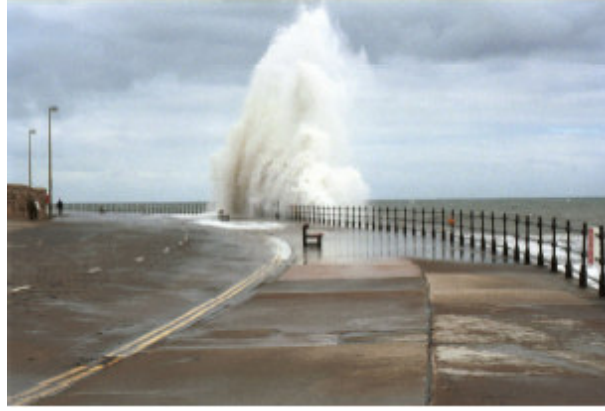
Şekil 1.3 Marine Drive’de dalga aşması (Scarborough, İngiltere 2002) [2]
