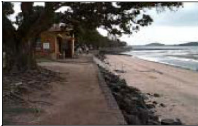
f) Eğimli ve anroşmanlı kıyı duvarı (Kohimarama) [1]
