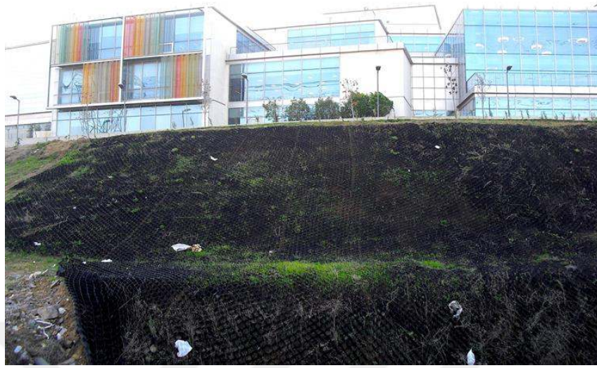
Şekil 5.5. Özyeğin Üniversitesindeki Geocell Uygulaması (Yapı, N., 2018).
