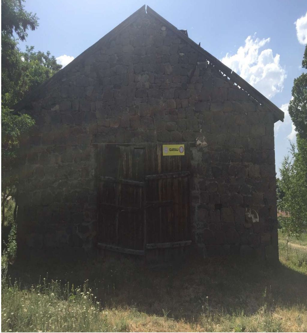
EK 18 Köy Enstitüsü'nün garaj binası.
