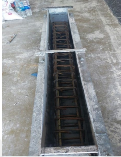
Şekil 3.5. Kalıplara donatının yerleştirilmesi
