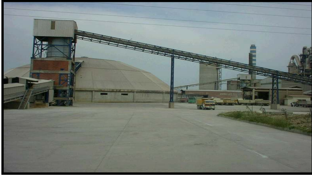
Şekil 6.2 Hammaddenin kırıcılardan sonra homojen olarak depo edilişi Akçansa A.Ş.
