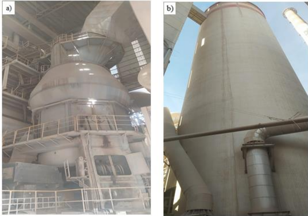
Şekil 6. Farin değirmenleri ve silosu, a) valsli farin değirmeni, b) farin homojene silosu
