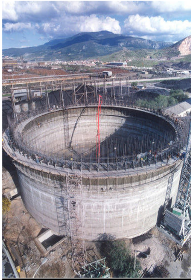
Resim 1.5: Çimentoş klinker silo inşaaı -1994
