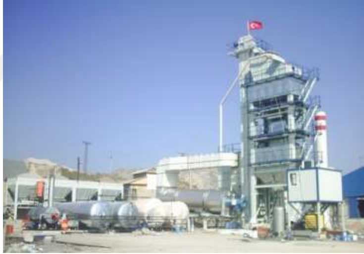
Şekil 3. Sıcak karışım asfaltların plentte üretilmesi
