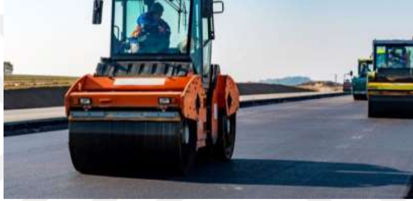
Şekil 1. Esnek üst yapı serimi
