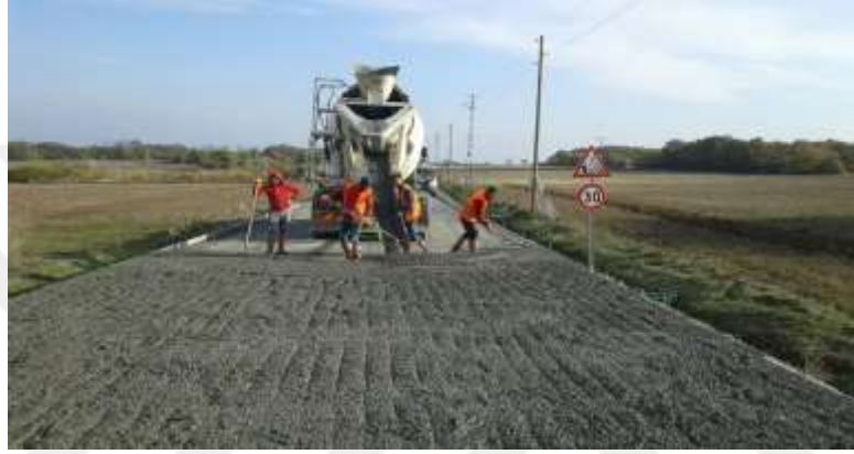
Şekil 2. Rijit üst yapı çalışması
