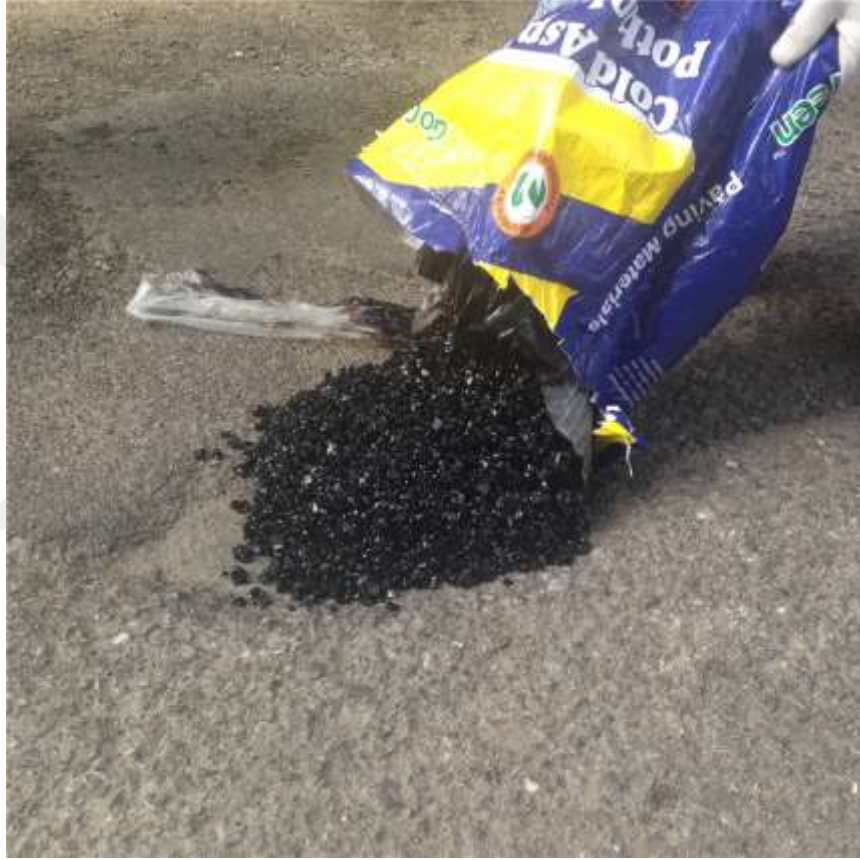
Şekil 4. Soğuk karışım asfaltlar ile dolgu işlemi
