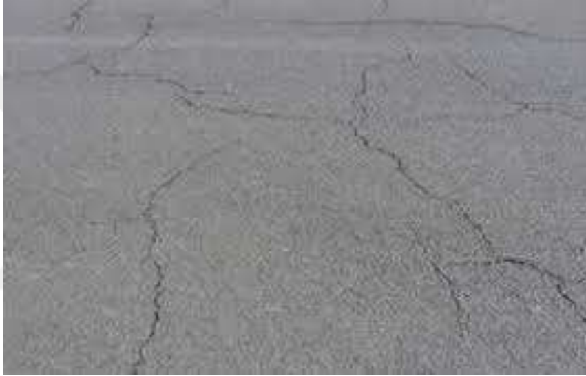
Şekil 14. Uzun hizmet ömrü sonrası yorulmuş ve yaşlanmış kaplama
