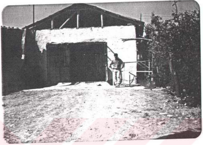
Foto 20: Poyraz köyündeki Demir Doğrama ve Kaynak Atölyesi.
