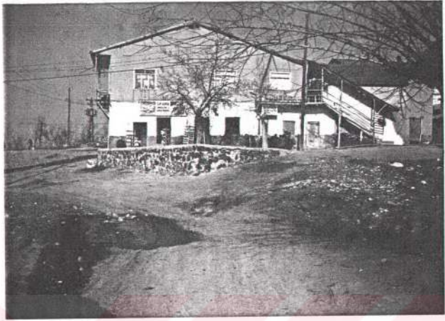
Foto 18: Cipe Köyünde, üst katı ev, alt katı ise bakkal, kahvehane, telefon santrali ve tüpgaz bayii olarak kullanılan bina.
