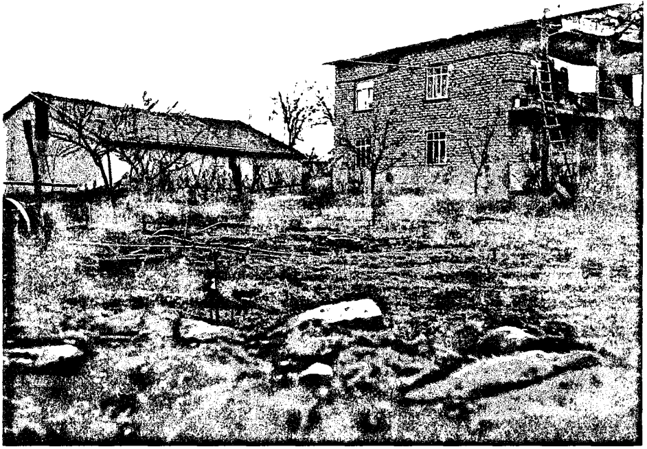
Foto 1: Cip Köyünde, kerpiçten yapılmış iki ayrı konut (Tek katlı olanın dışı çimento harcı ile sıvanmıştır).
