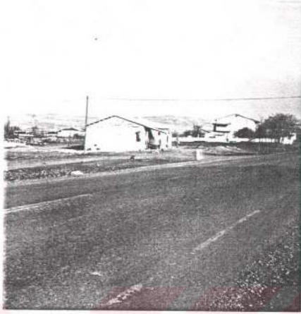
Foto 22: Cip Köyündeki değirmen.
