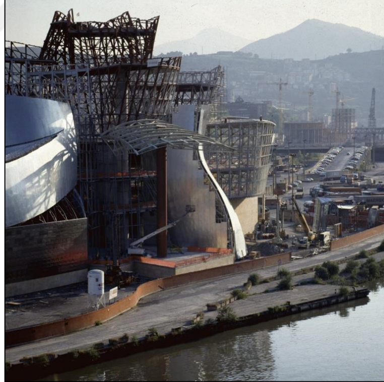
Görsel 3.51. Guggenheim Müzesi yapım aşaması (http-44)
