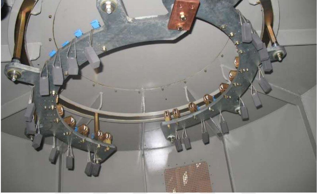
Resim 2.2. Generatör bilezik-fırça yapısı örneği (Orijinal)
