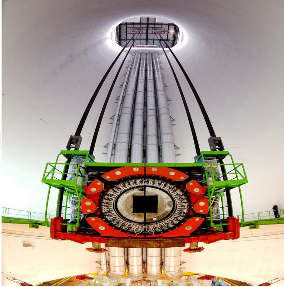
Şekil 2.15. HF Kalorimetresinin yer altına indirilişi ( https://cds.cern.ch/record/1431489 ).
