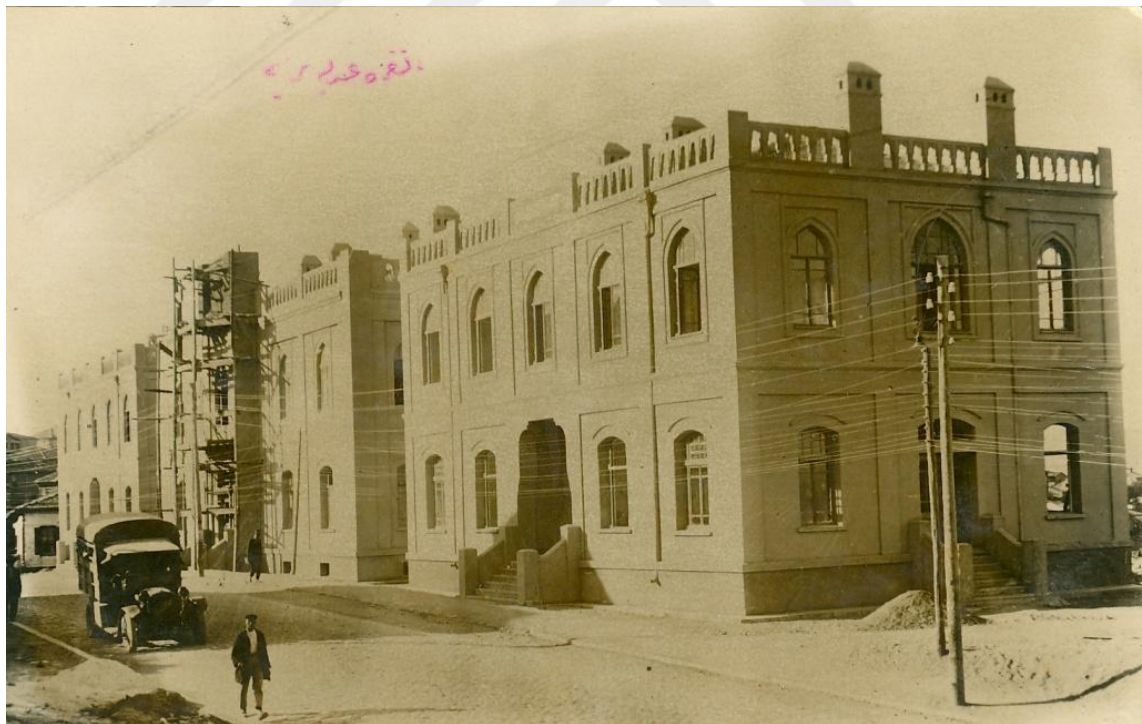
Res. 6. Kuzeybatı Cephe Genel Görünüm, 1926-1927, (Vekam 0997).
