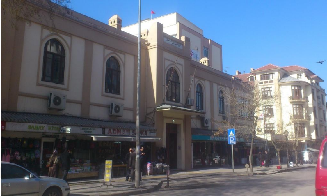
Res. 11. Kuzeydoğu Cephe, Zemin Kat Dükkanlar, Aralık 2017, Simin ŞAY Arşivi.
