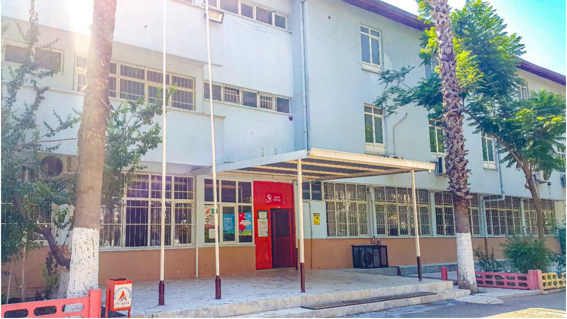
Şekil 130. Antalya Çocuk Evi Sitesi idare binası fotoğrafı
