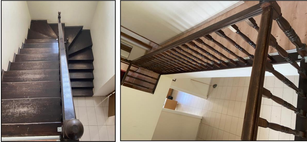
Şekil 100. Sur Çocuk Evi Sitesi idari bina merdiven
