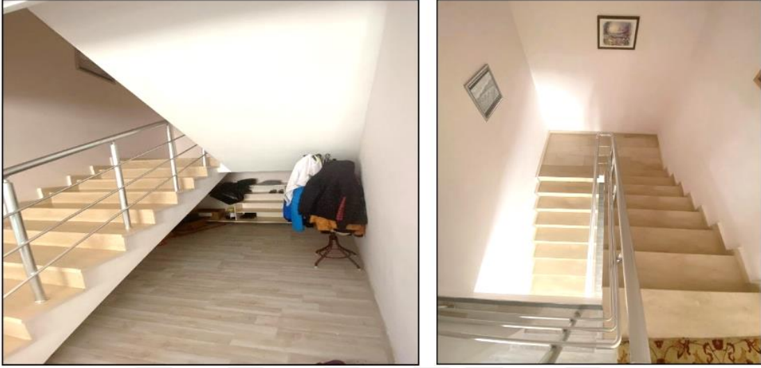
Şekil 89. Diyarbakır Ayşe Hafsa Sultan Çocuk Evi Sitesi evin merdiven görüntüsü
