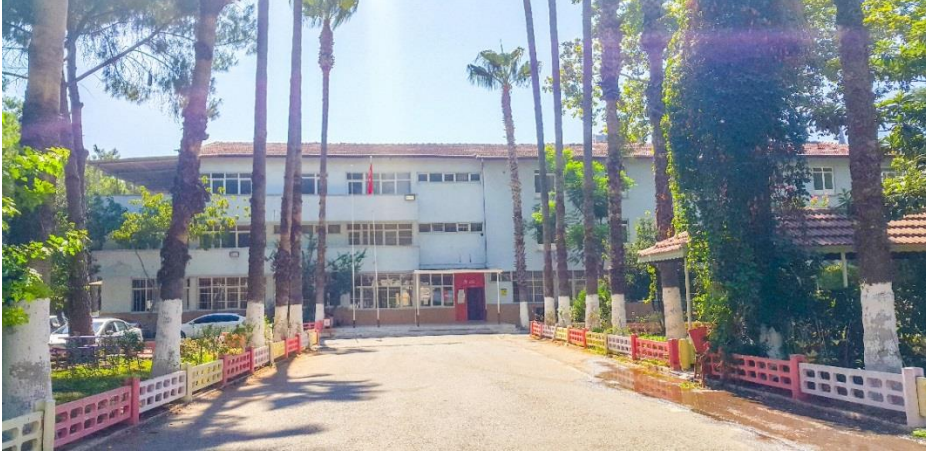
Şekil 129. Antalya Çocuk Evi Sitesi idare binası fotoğrafı
