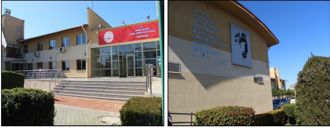
Şekil 39. Adana Çocuk Evi Sitesi idari bina dış cephe görüntüleri
