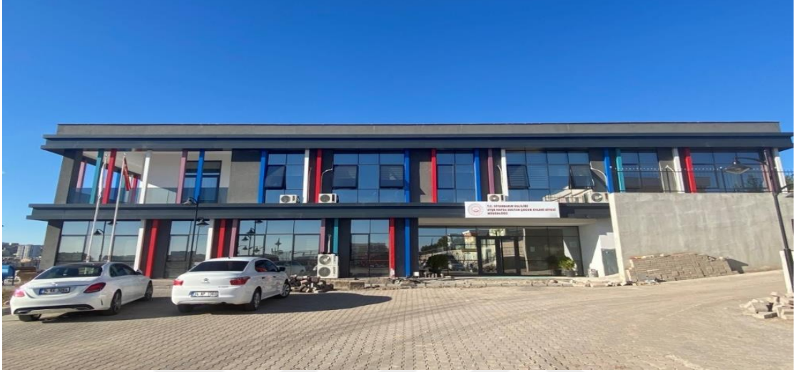
Şekil 75. Diyarbakir Ayşe Hafsa Sultan Çocuk Evi Sitesi idari bina görüntüsü
