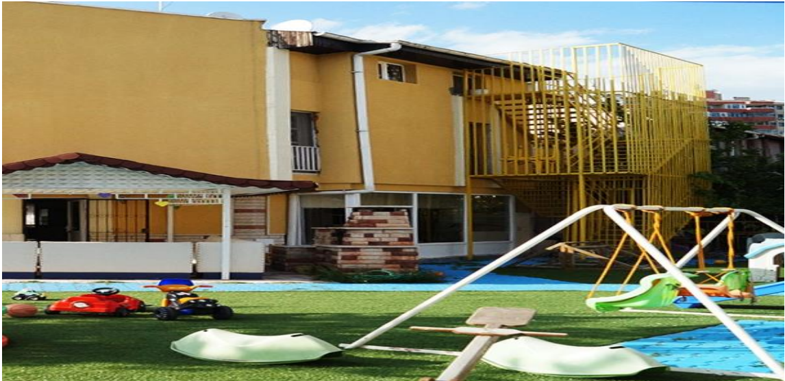
Şekil 29. Çocuk evlerinde bulunan yangın merdiveni örneği
