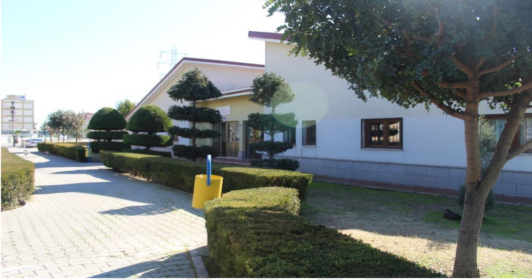
Şekil 62. Adana Çocuk Evi Sitesi revir binası cephe görünüşü
