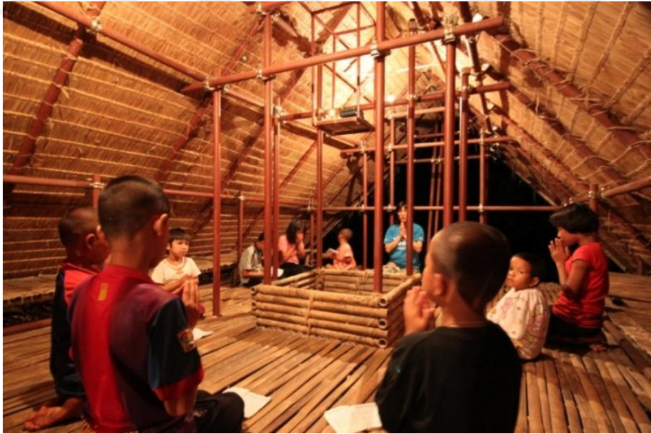
Görsel 5.8. Shangkhaburi Köy Okulu yapım tekniği bileşenlerinden yuvarlak kum torbaları, hafif çelik strüktür ve bambu üst örtü; https://www.archdaily.com/630188/floating-in-the-sky-school-for-orphans-kikuma-watanabe , erişim tarihi: Kasım 2018
