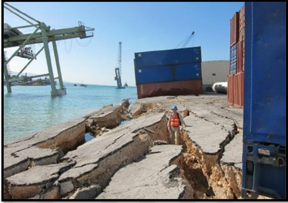
Şekil 16.Haiti’de 2010 yılında deprem sonrasında meydana gelen yanıl deplasman (Desroces, Comerio, Eberhang, Mooney,& Rix, 2011, s.26).
