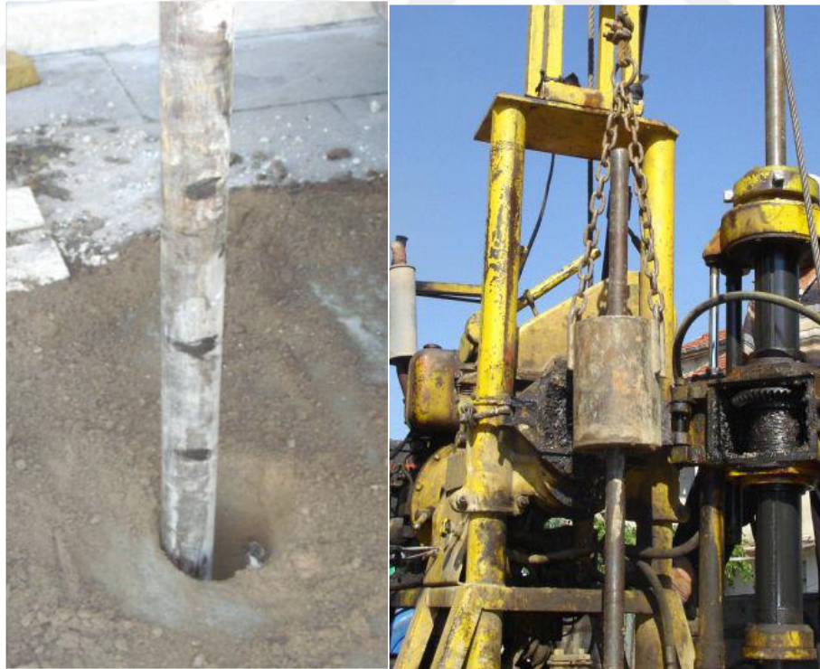
Şekil 32. Tijlerin işaretlenmesi ve çakma balığı üzerine şahmerdanın yerleştirilmesi.
