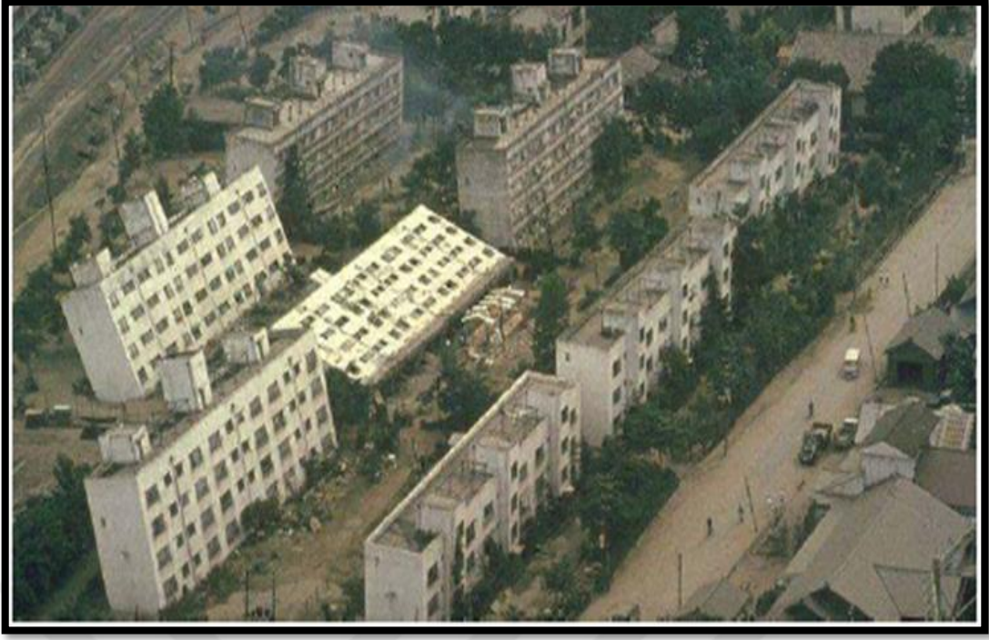
Şekil 17. 1964’de Niigata’daki depremde sıvılaşma nedenli taşıma gücü kaybı sonucu devrilen yapılar (Day, 2002).
