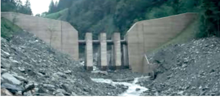
Şekil 1.10. Geçirgen Tersip Bendi (Anonim, 2022c)
