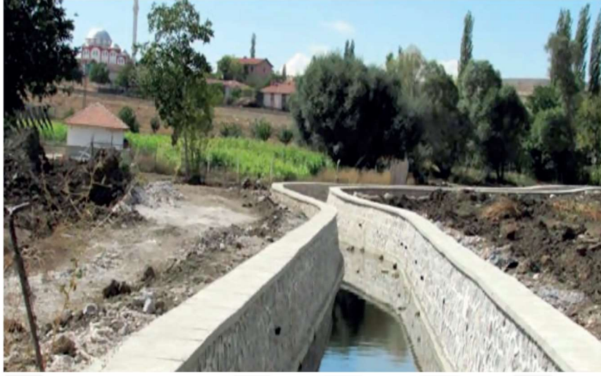
Şekil 1.6. Duvarlı Taş Tahkimat Görüntüsü (Bartın) (Anonim, 2022c)
