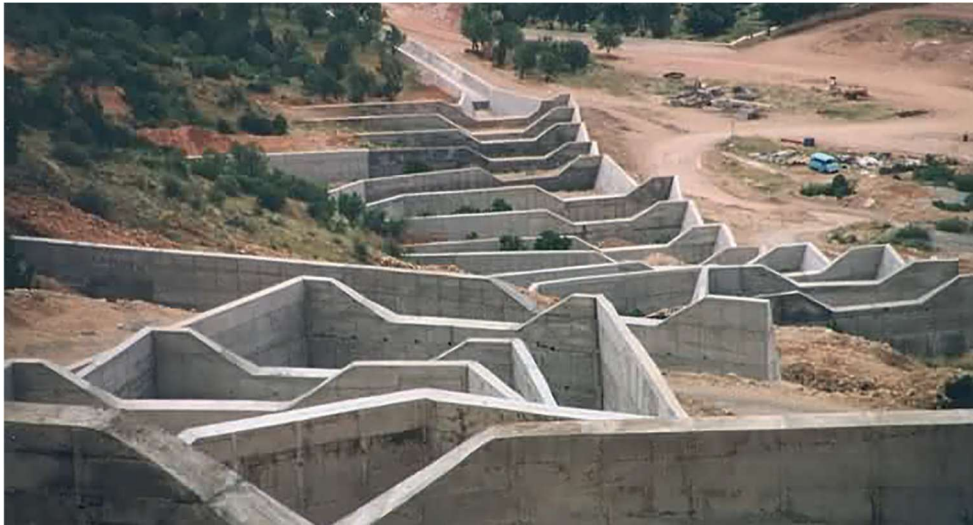
Şekil 1.11. İslah Sekisi Görüntüsü (Isparta) (Anonim, 2022c)
