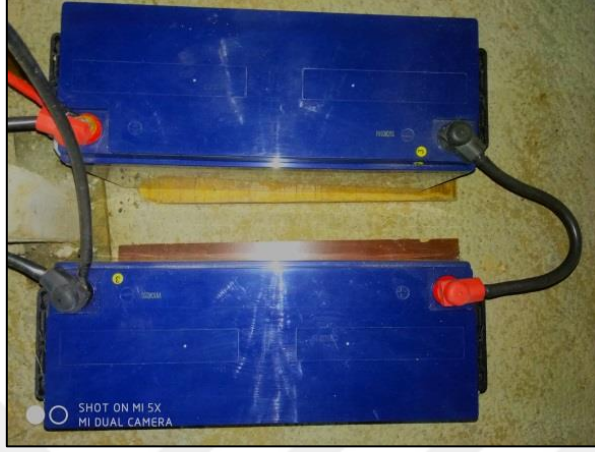
Şekil 4.7. Seri bağlı 12V 150Ah jel batarya grubu
