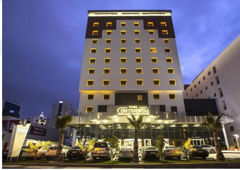
Şekil 29 : Gaziantep Teymur Continental Otel
