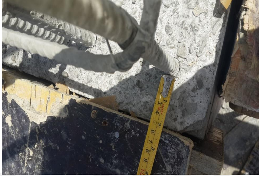
Şekil B.3. Binanın döküzcü kat kolon kesiti
