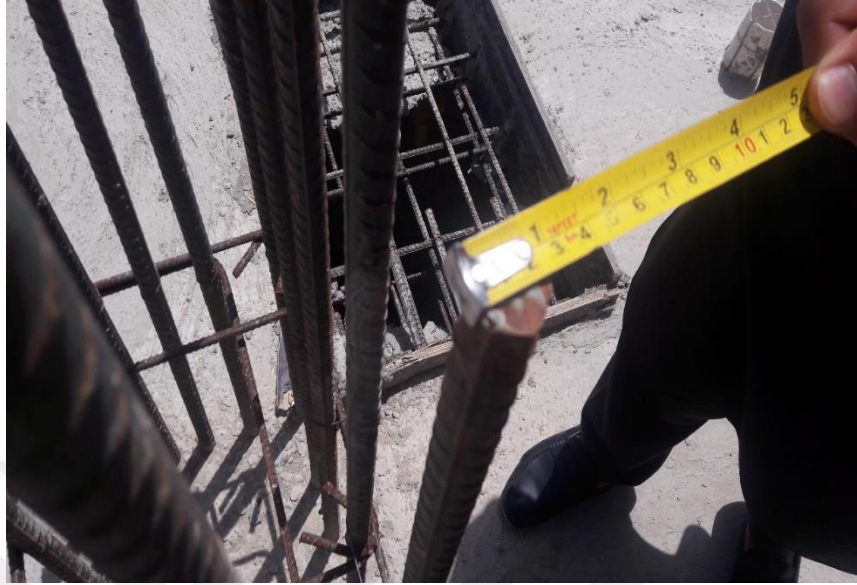
Şekil B.1. Binanın ikinci kat kolon donatısı
