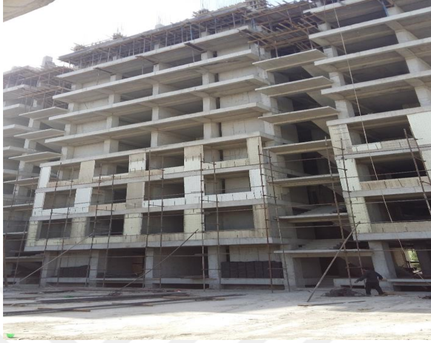
Şekil B.7. Binanın arka görünümü
