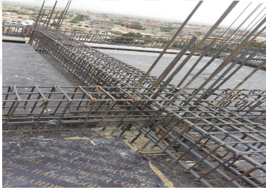
Şekil B.6. Binanın döküzcü kat kiriş kesiti
