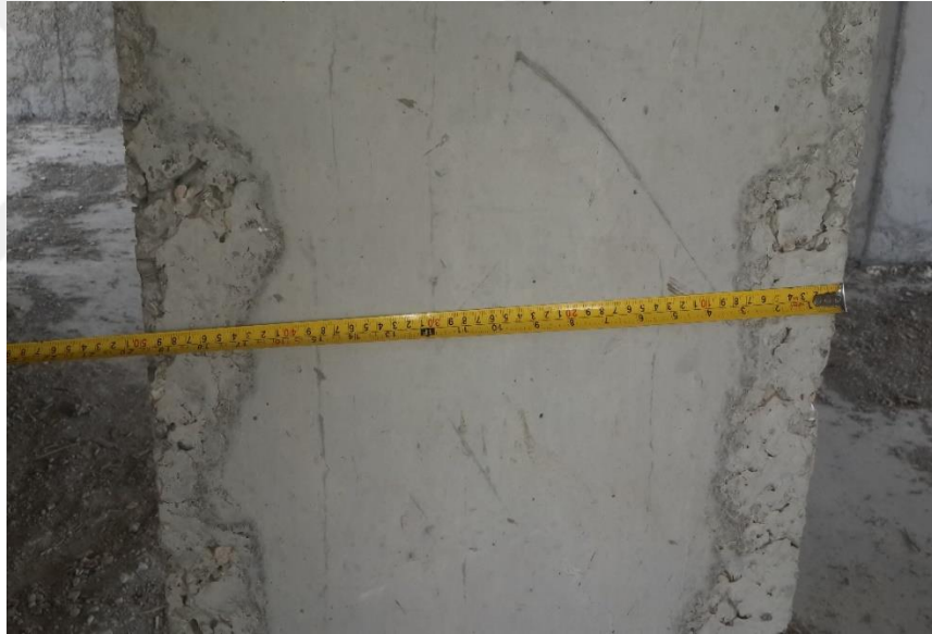
Şekil B.4. Binanın ikinci kat kolon boyutu
