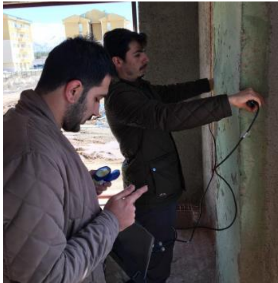
Şekil 3.9. Ultra Ses Cihazı İle Yapı Taşıyıcı Elemanlarının Muayenesi
