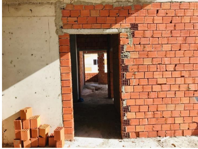
Şekil 4.7. Dolgu Duvarlar İle Kiriş Arasındaki Boşluğun Kaldırılması
