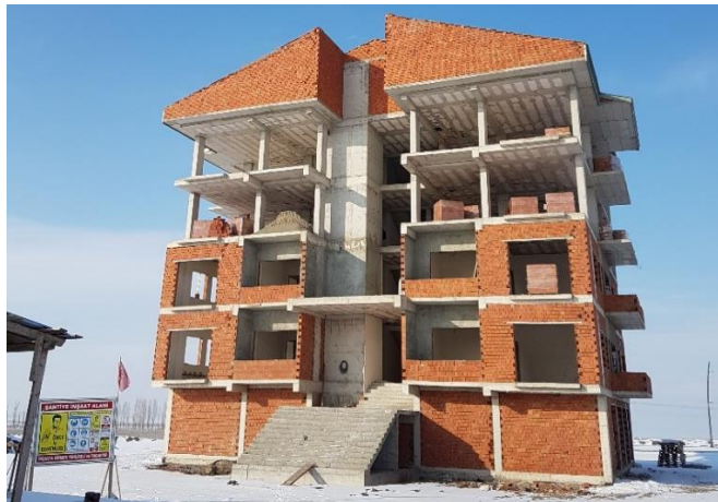
Şekil 3.52. Birinci Ölçüm Tarihinde 9. Blok İmalat Durumu I
