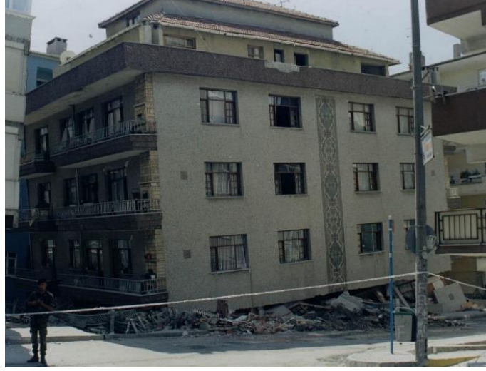
Şekil 3.23. Deprem Yönetmeliklerinde Bahsi Geçen B2 Yapı Düzensizliği
