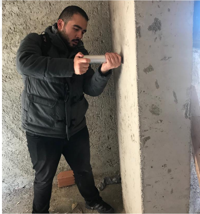
Şekil 3.8. Schmidt Sertlik Çekici Cihazı İle Yapı Taşıyıcı Elemanlarının Muayenesi
