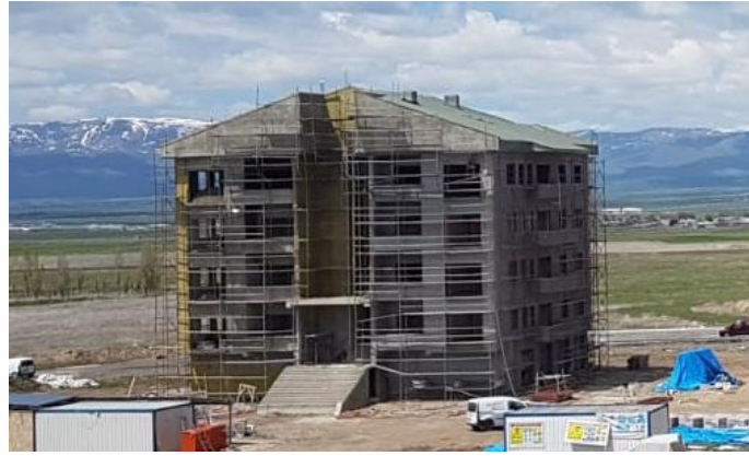
Şekil 3.54. 9. Blok İçin Yapılan İkinci Ölçümdeki Bina Durumu
