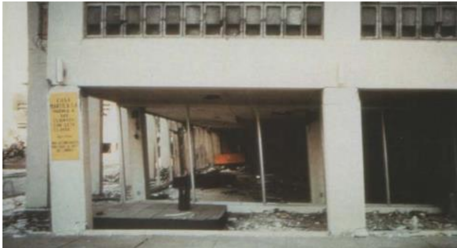
Şekil 3.22. Deprem Yönetmeliklerinde Bahsi Geçen B1 Yapı Düzensizliği
