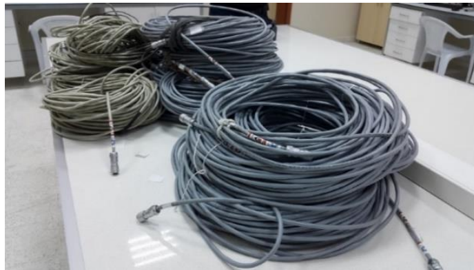
Şekil 3.34. İvmeölçerlerin Veri Toplama Sistemine Bağlantı Kabloları
